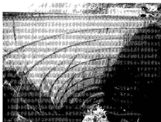
図-1 アーチダム背面のキャットウォーク
