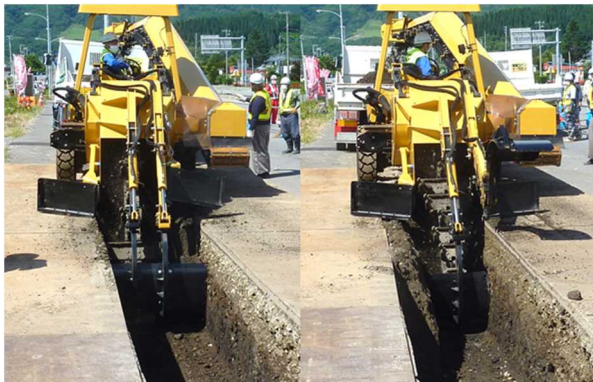
写真-17 トレンチャーでの掘削状況 （左：2回目、右：1回目）
