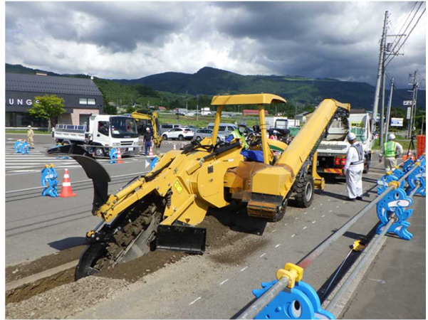
写真-15 トレンチャーによる施工状況
