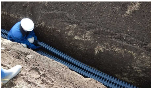
写真-7 角形多条管の接続状況
