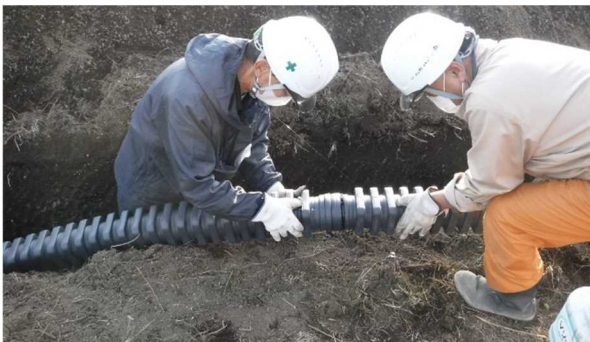
写真-12 角型多条管の接続
