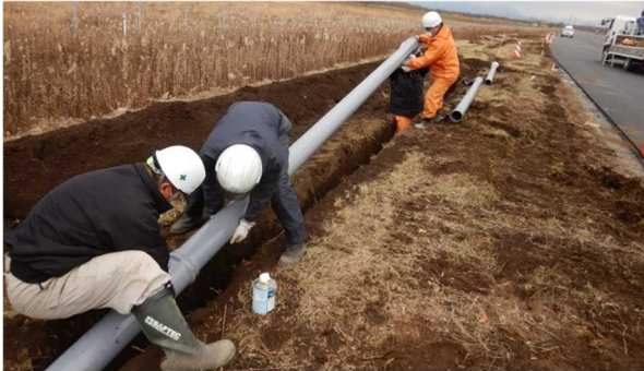
写真-11 FA 管の接続状況
