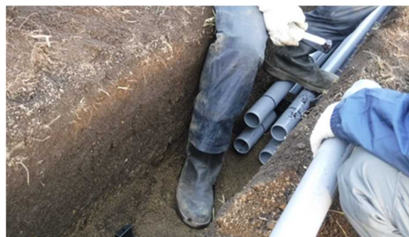
写真-5 RR-VE管の接続状況
