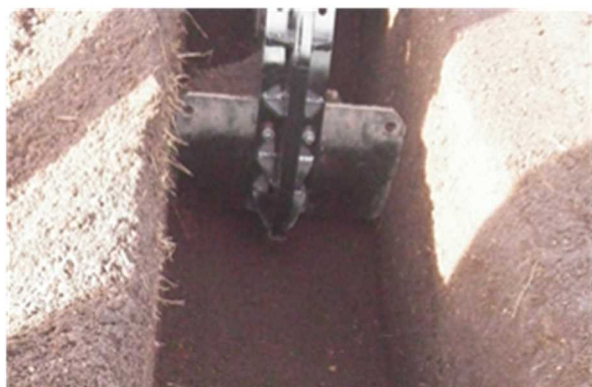
写真-4 トレンチャー掘削後の仕上り状況
