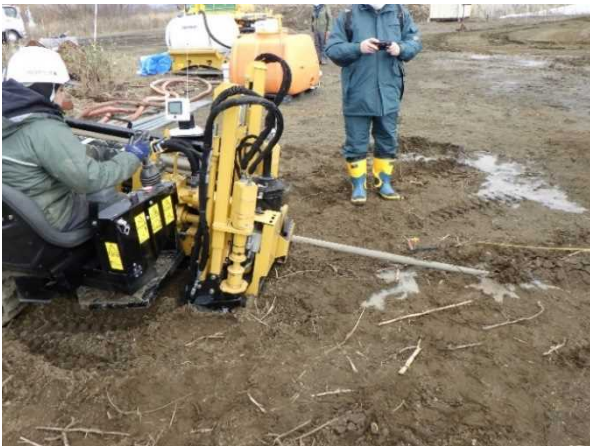
写真-23 施工状況
