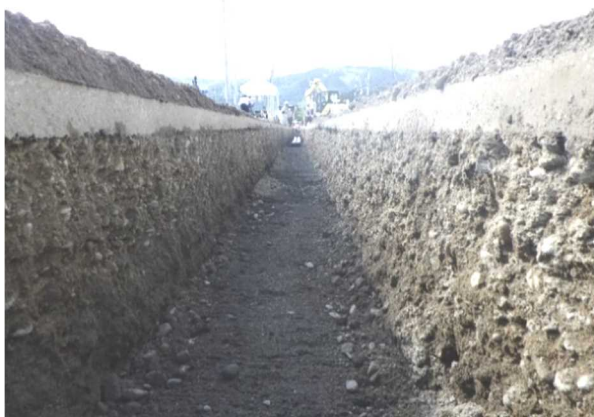
写真-16 掘削後の仕上がり
