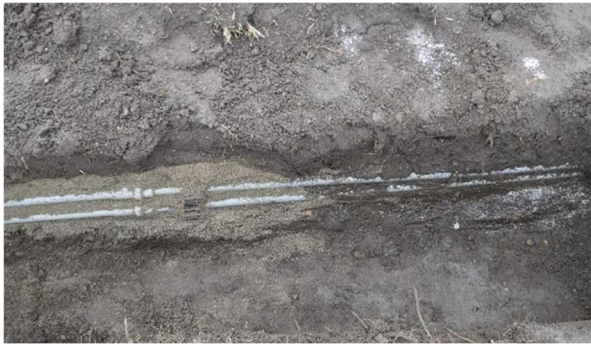
写真-6 埋戻し材の充填状況 (左側：砂、右側：発生材)
