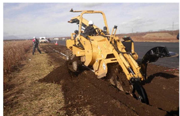
写真-3 掘削状況
