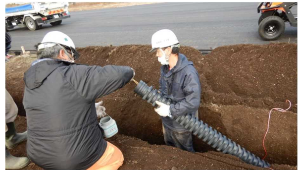
写真-9 角形多条管の接続状況
