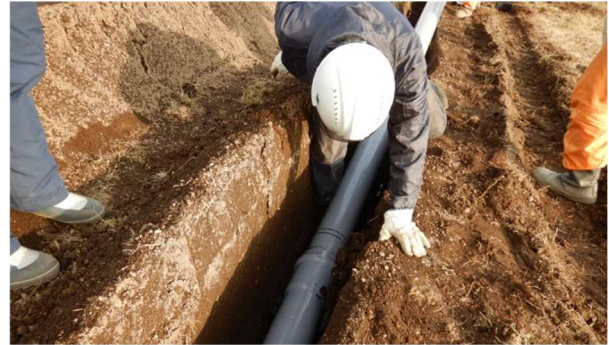
写真-8 FA 管の接続状況
