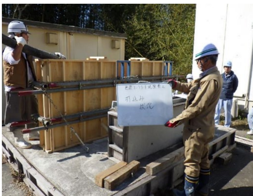
写真-4.5.17 模擬部材打設実験における打込み時の状況
