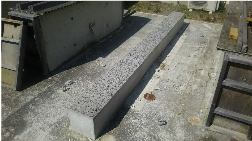
写真-4.5.12 打継ぎ部の外観状況
