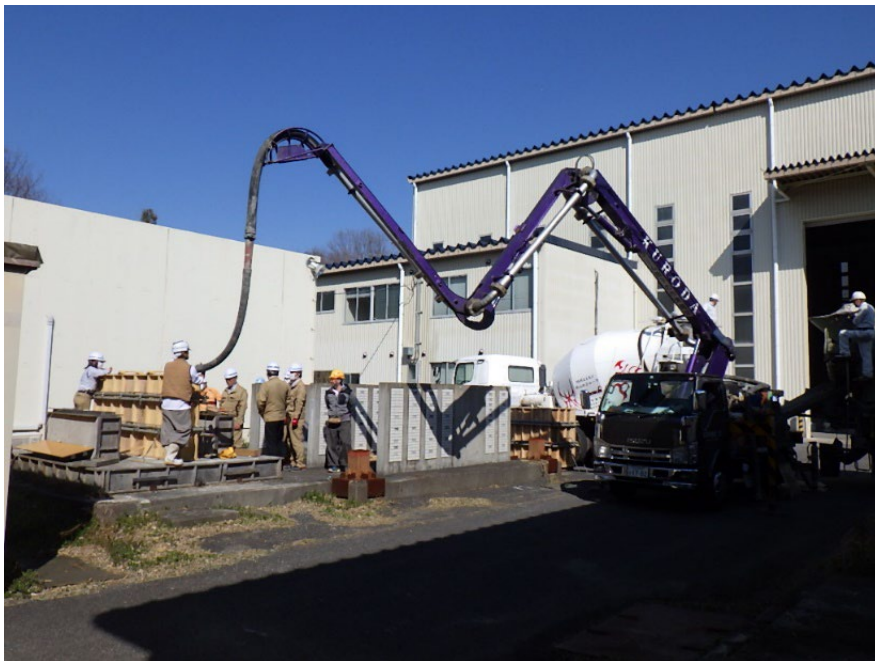
写真-4.5.15 繊維混入急硬コンクリートの打込み状況
