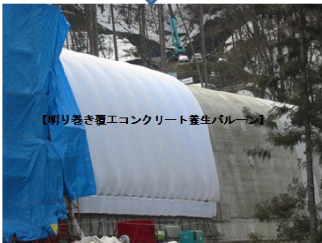
図-4.4.1 明り巻き覆工コンクリート養生バルーン説明図(その1)
