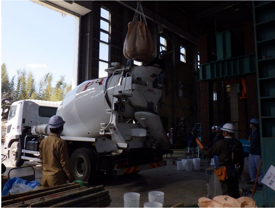
写真-4.5.14 繊維混入急硬コンクリートの製造状況
