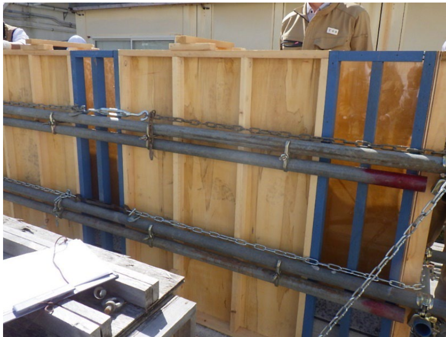
写真-4.5.13 模擬型枠
