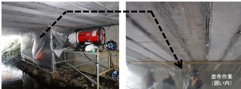
写真 26-1 施工現場の様子
