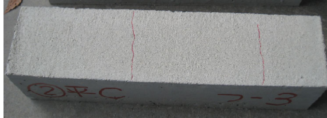
(3) 暴露3年でのひび割れの状況
