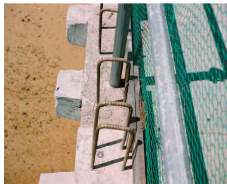
写真-9.4 地覆埋込鉄筋 SUS 鉄筋配置
