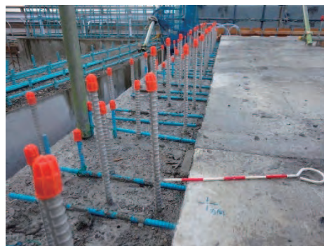
写真-9.6 伸縮装置部埋設鉄筋 SUS 鉄筋配置
