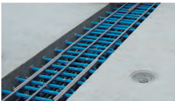
写真-9.2 ループ継手部 SUS 鉄筋配置
