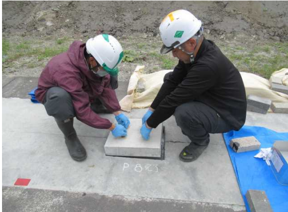
写真-3.9 コンクリート基礎設置状況
