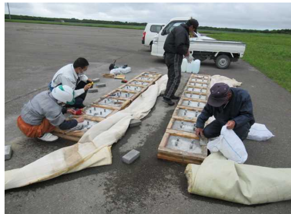
写真-3.8 コンクリート基礎型枠撤去
