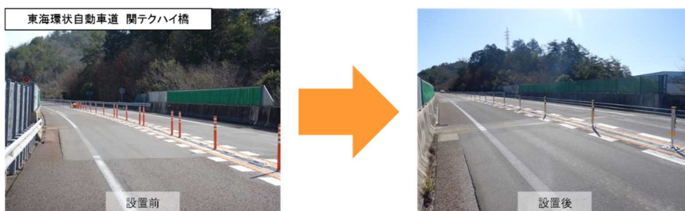
写真-2.14 試行設置状況（東海環状自動車道関テクハイ橋）
