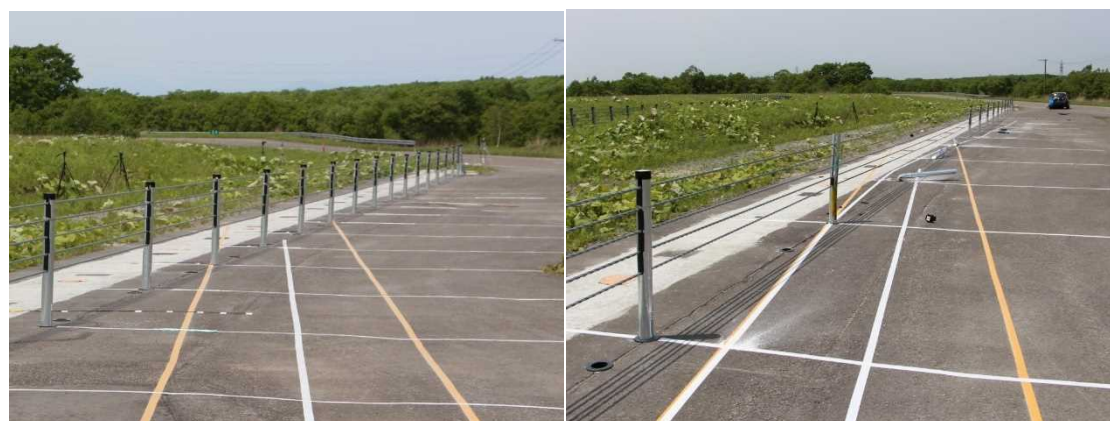
写真-4.2 ワイヤロープ式防護柵設置状況（左：乗用車試験前、右：乗用車試験後）
