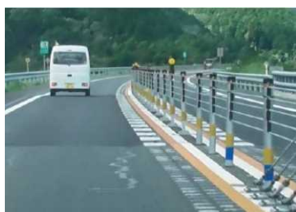
写真-2.15 松山道・大谷川橋
