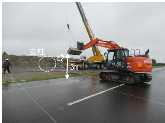
写真-3.1 支柱衝突試験
