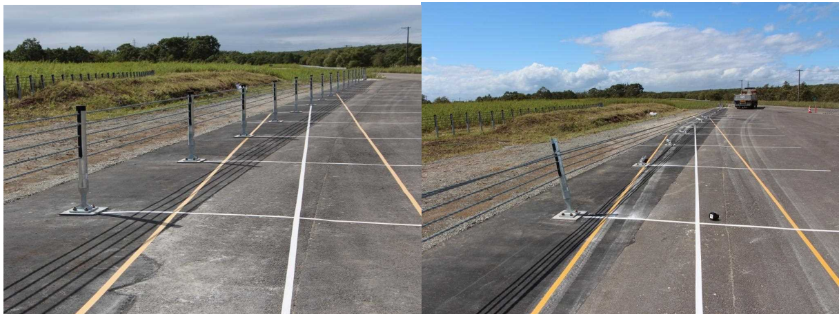
写真-2.10 性能確認試験（左：試験前、右：試験後）
