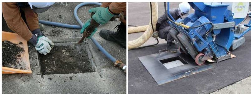
写真-2.7 舗装開削（左）と床版表面処理（右）
