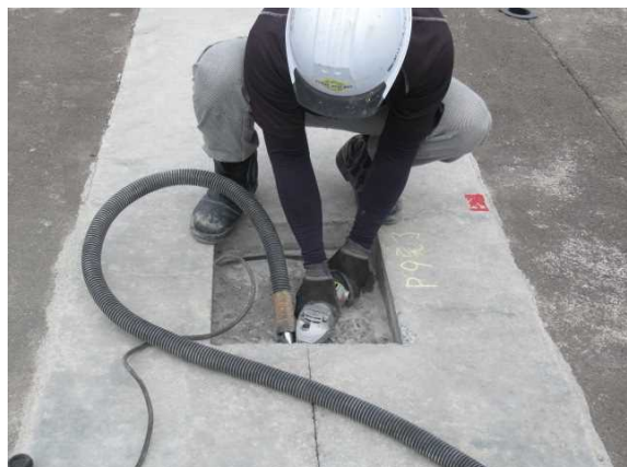
写真-3.3 ディスクサンダー処理
