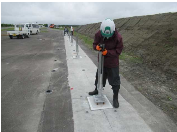
写真-3.11 支柱建込み状況
