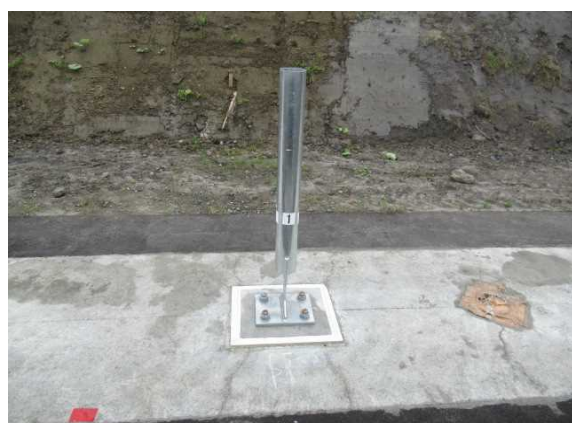
写真-3.12 支柱設置状況
