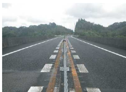
写真-2.16 東九州道・下村川橋
