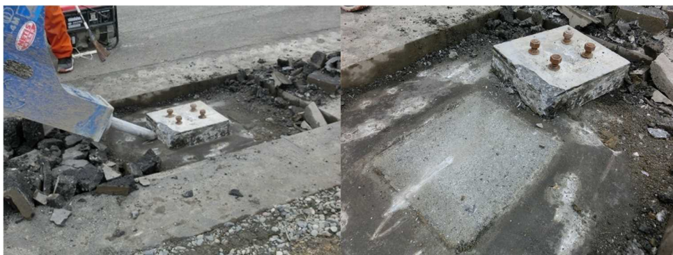
写真-2.13 コンクリート基礎の撤去
