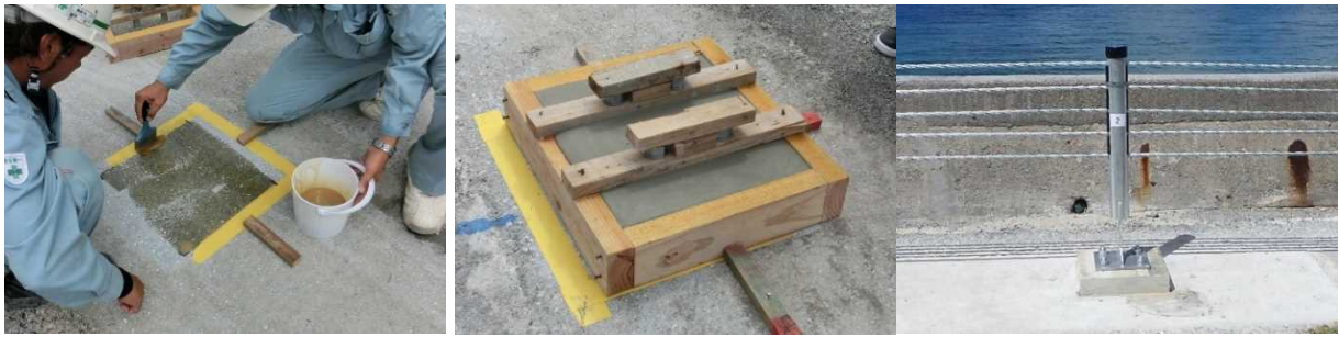
写真-2.5 支柱コンクリート基礎打設状況
