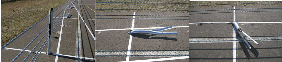
写真-4.4 大型車衝突後の支柱の損傷状況
