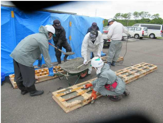
写真-3.7 コンクリート基礎打設状況
