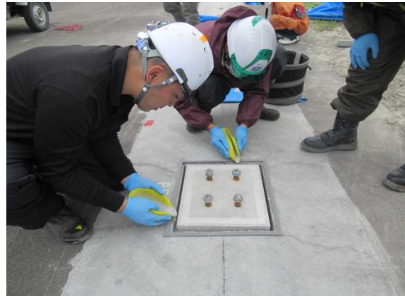
写真-3.10 TB ボンド注入状況
