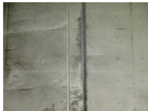
写真-8 開いた継手部の止水の例
