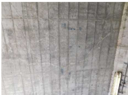
(b) 乾燥収縮によると考えられる不規則なひびわれ 写真-1 頂版のひびわれの例
