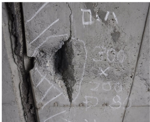
写真-6 うき・剥離のたき落とし後の様子の例
