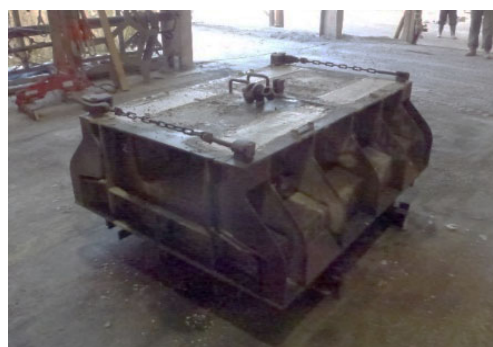
(b) 製作状況(鋼製型枠を使用)
