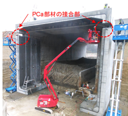
写真-1 機械式鉄筋継手を用いた PCa 部材同士の接合例
