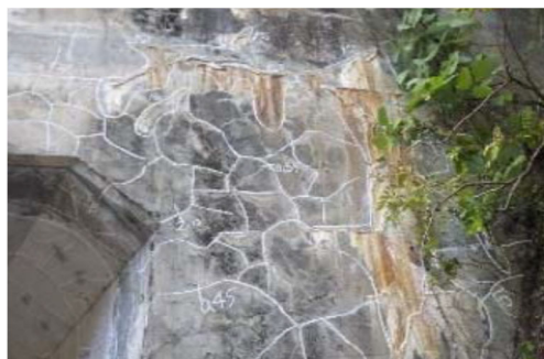
(a) アルカリ骨材反応によるひびわれ
