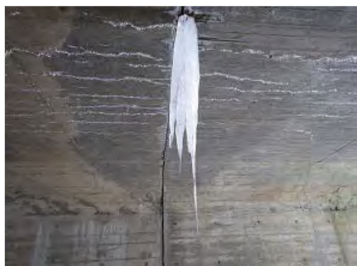
(d) 頂版継手部の氷柱
