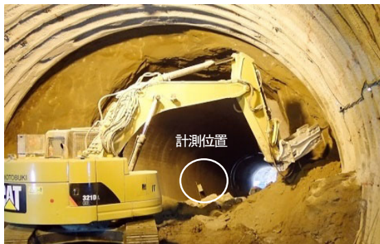
写真-4 掘削、計測状況 (A トンネル)
