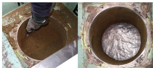
写真-3 \phi 300 掘削状況
