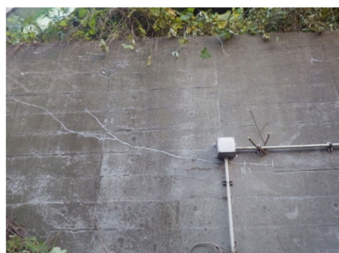
(b) 乾燥収縮によるひびわれ
