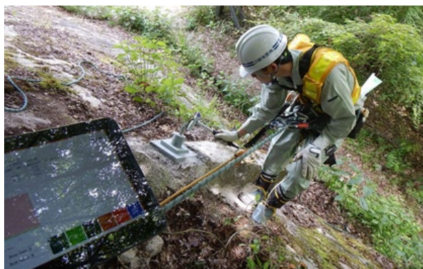
写真-3 ボルトテスターによる調査状況
