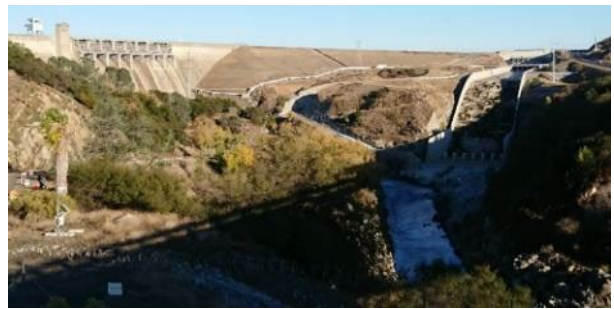
図-1 Folsom dam : 写真右側が増設された洪水吐き
