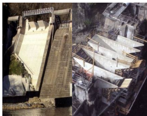
図-6 PKWが採用された Saint-Marc dam (左：完成後下流面、右：施工途中) 5)
