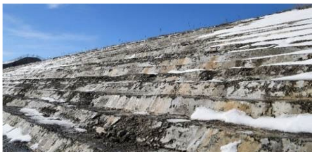
図-4 Leyden dam : 堤体下流面をRCCで階段状に保護
