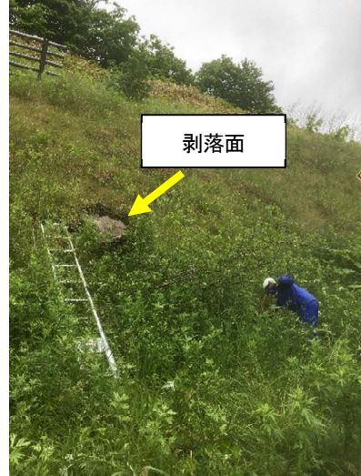
写真-4 苫前町の中和緑化工法施工地点
