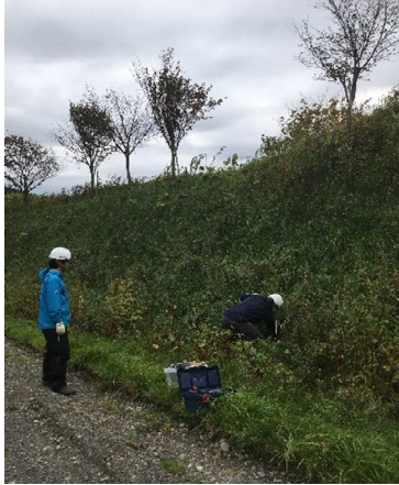
写真-1 天塩町の中和緑化工法施工地点
