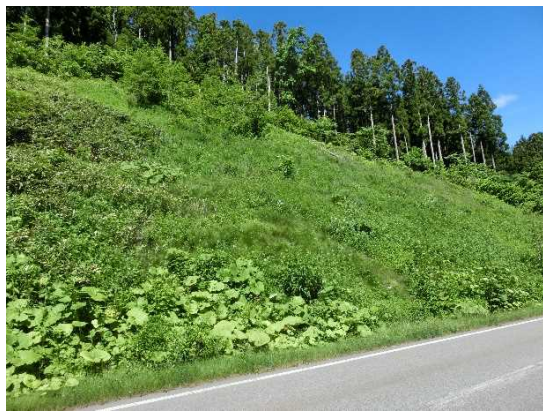
写真-2 北斗市の中和緑化工法施工地点
