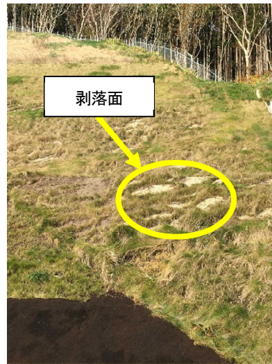
写真-5 木古内町の中和緑化工法施工地点
