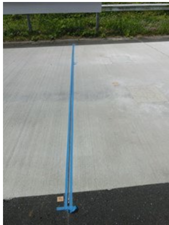
写真-4.3.7 バックアップ材挿入
