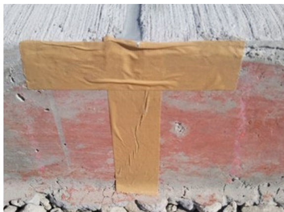
写真-5.5.10 シリコーン目地仕上がり状況 (断面②) ※誘導ひび割れあり
