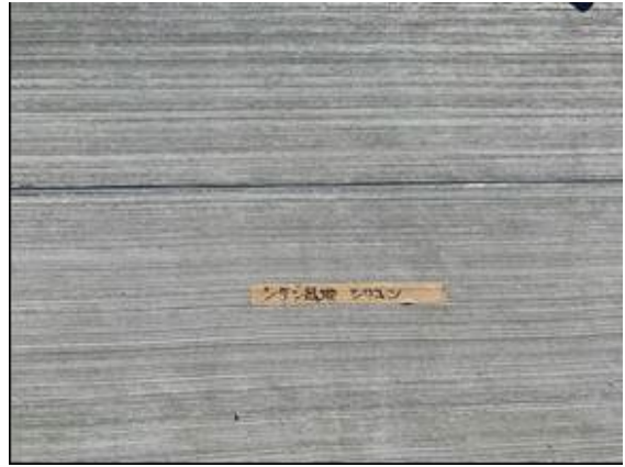
写真-5.4.8 シリコン目地仕上がり状況
