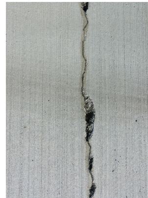
写真-4.3.18 プライマー塗布後
