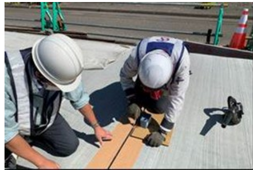
写真-5.4.2 トスプライムC塗布状況
