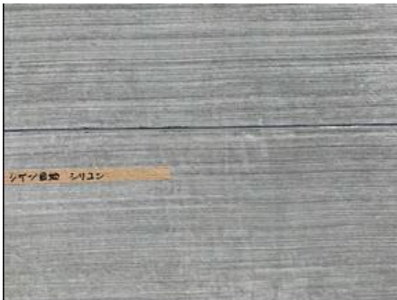
写真-5.5.3 シリコン目地仕上がり状況（断面①）
