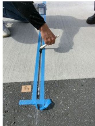
写真-4.3.8 プライマー塗布
