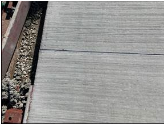
写真-5.5.1 シリコン目地仕上がり状況（断面①）
