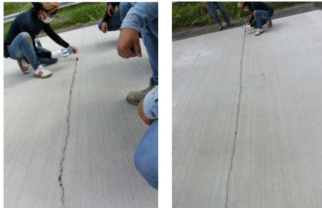
写真-4.3.12 プライマー塗布
