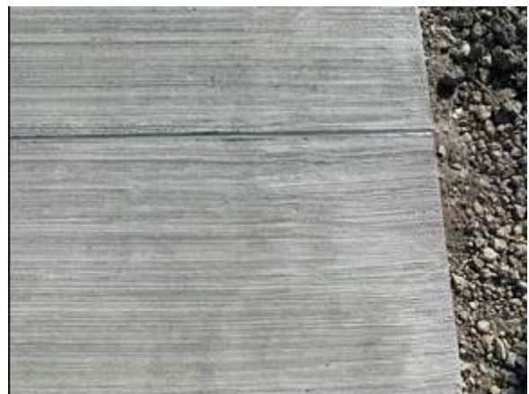
写真-5.5.9 シリコーン目地仕上がり状況 (断面②)
