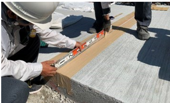
写真-5.4.3 バックアップ材(設置深さ2cm)
