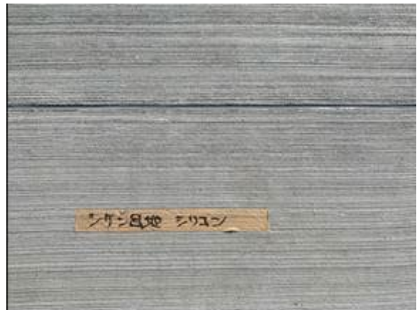
写真-5.5.7 シリコーン目地仕上がり状況 (断面②)
