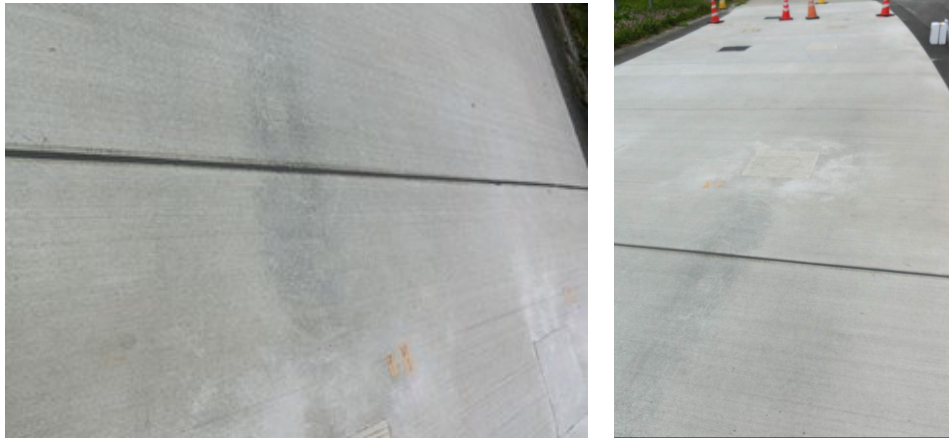
写真-4.3.10 ヘラ仕上げ後
