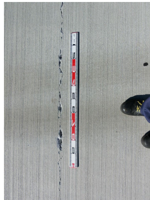
写真-4.3.17 破片除去後
