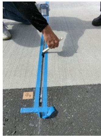
写真-4.3.2 プライマー塗布
