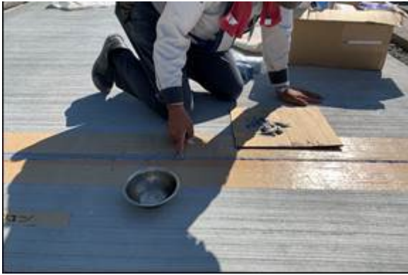
写真-5.4.7 表面仕上げ（洗剤をつけた指で整形）
