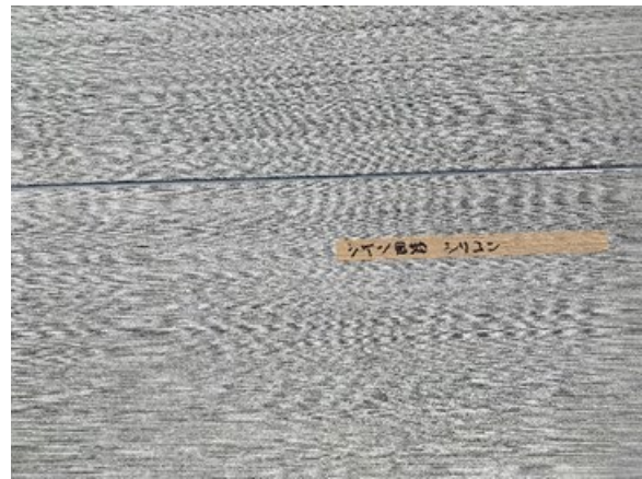
写真-5.5.2 シリコン目地仕上がり状況（断面①）
