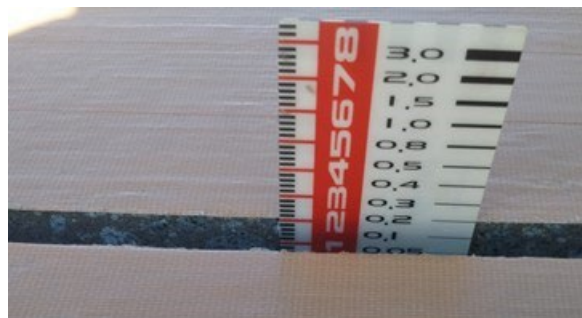
写真-5.4.4 バックアップ材(設置深さ2cm)
