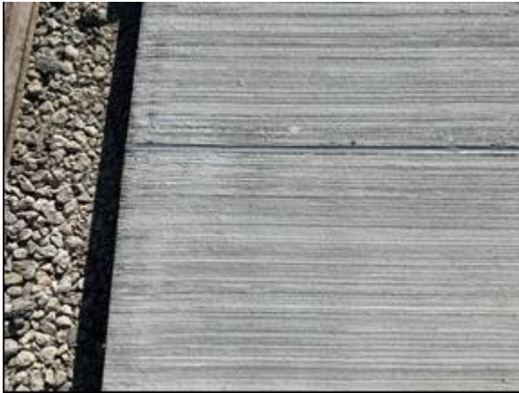
写真-5.5.6 シリコーン目地仕上がり状況 (断面②)
