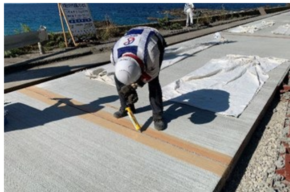
写真-5.4.6 シリコン系目地材注入状況
