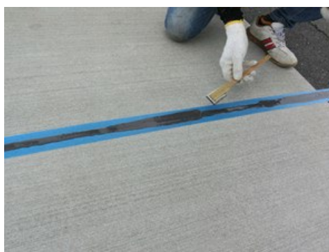
写真-4.3.9 ヘラ仕上げ作業
