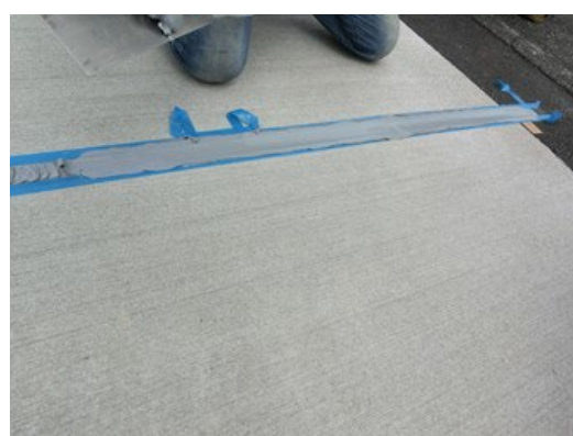
写真-4.3.4 ヘラ仕上げ
