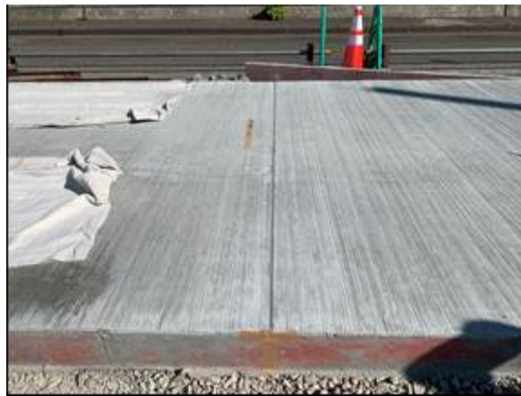
写真-5.4.9 シリコン目地仕上がり状況
