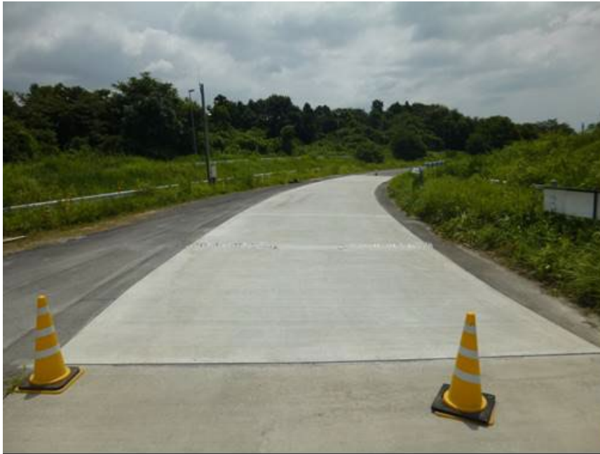
写真-4.1.3 新規コンクリート舗装工区全景
