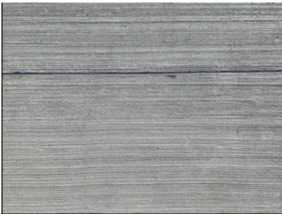
写真-5.5.8 シリコーン目地仕上がり状況 (断面②)
