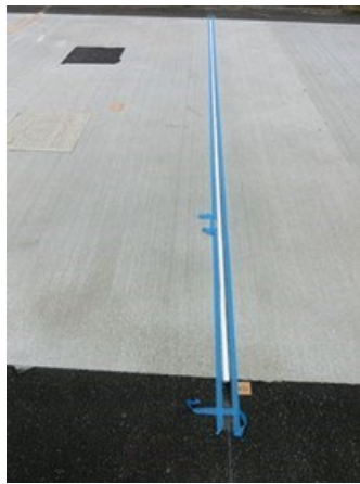
写真-4.3.1 バックアップ材挿入
