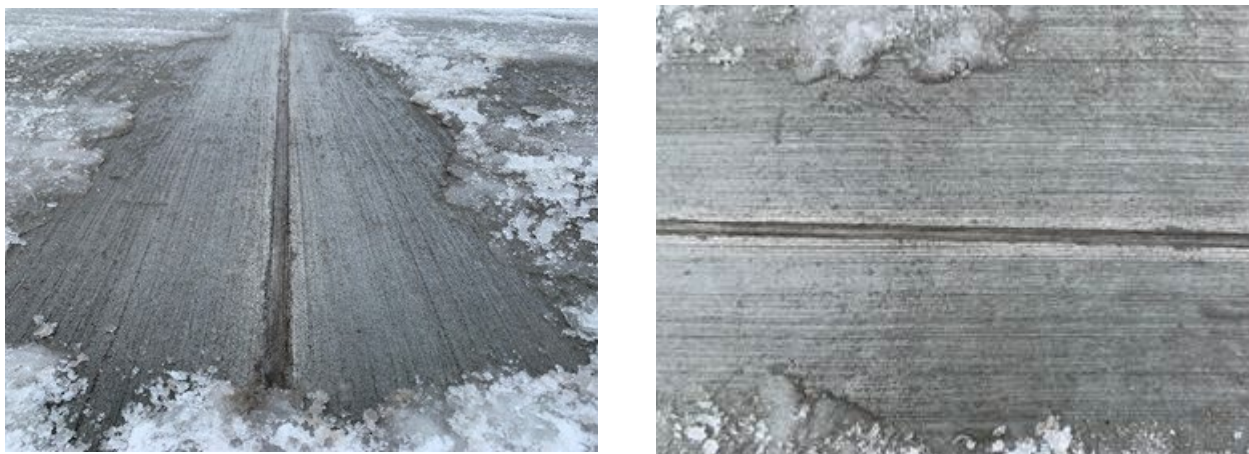
写真-5.6.2 施工から半年経過後（冬期）の目地の状況
