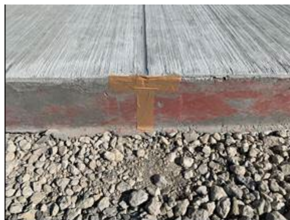
写真-5.5.5 シリコン目地仕上がり状況（断面①）
