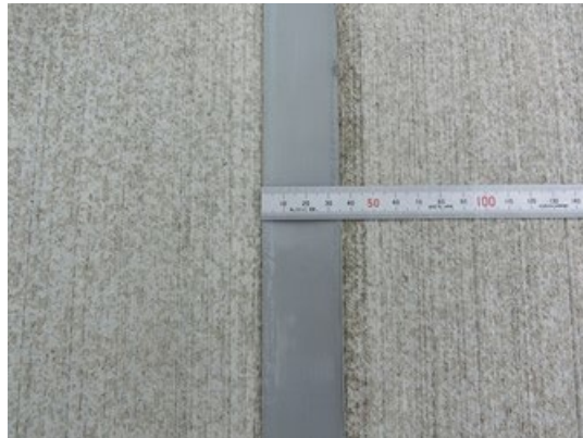
写真-4.3.5 作業完了後
