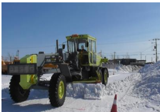
図-10 除雪試験の状況
