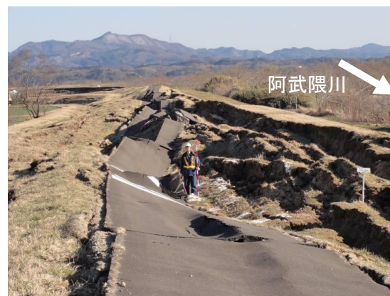
写真 3.1 堤防被災事例（堤体砂質土） 1) 阿武隈川水系阿武隈川（宮城県角田市枝野）
