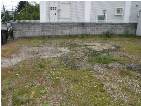
図-2.17 調査箇所②で確認された噴砂 （平成30年（2018年）9月9日撮影）
