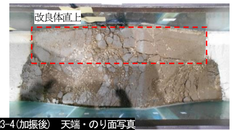
写真 3.10 実験後の堤体の亀裂状況 (CaseR3-4)
