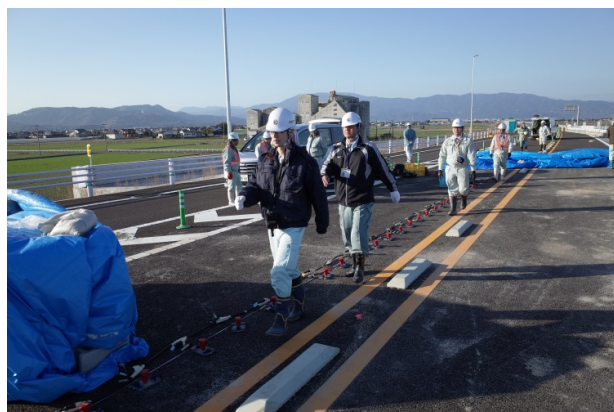
図-2.9 現場担当者との共同による計測調査風景
