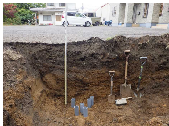
図-2.27 ブロックサンプリング、攪乱試料採取後の状況
