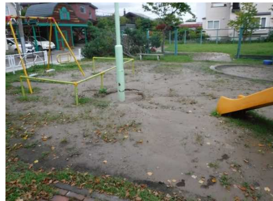
図-2.16 調査箇所①で確認された噴砂 （平成30年（2018年）9月9日撮影）
