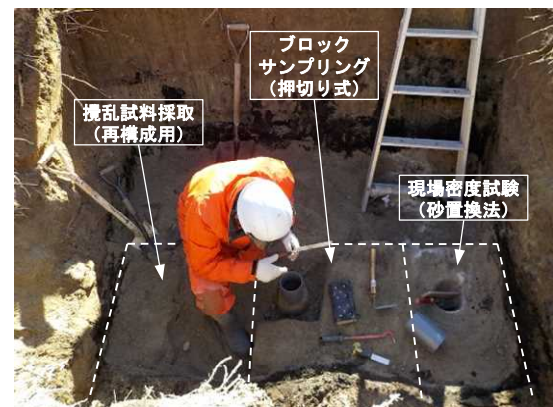
図-2.2 箇所 No.2 のブロックサンプリング状況 (同様の作業を隣接した3箇所 (No. 1~3) で実施)
