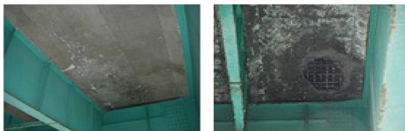
(a) 前回の定期点検時
