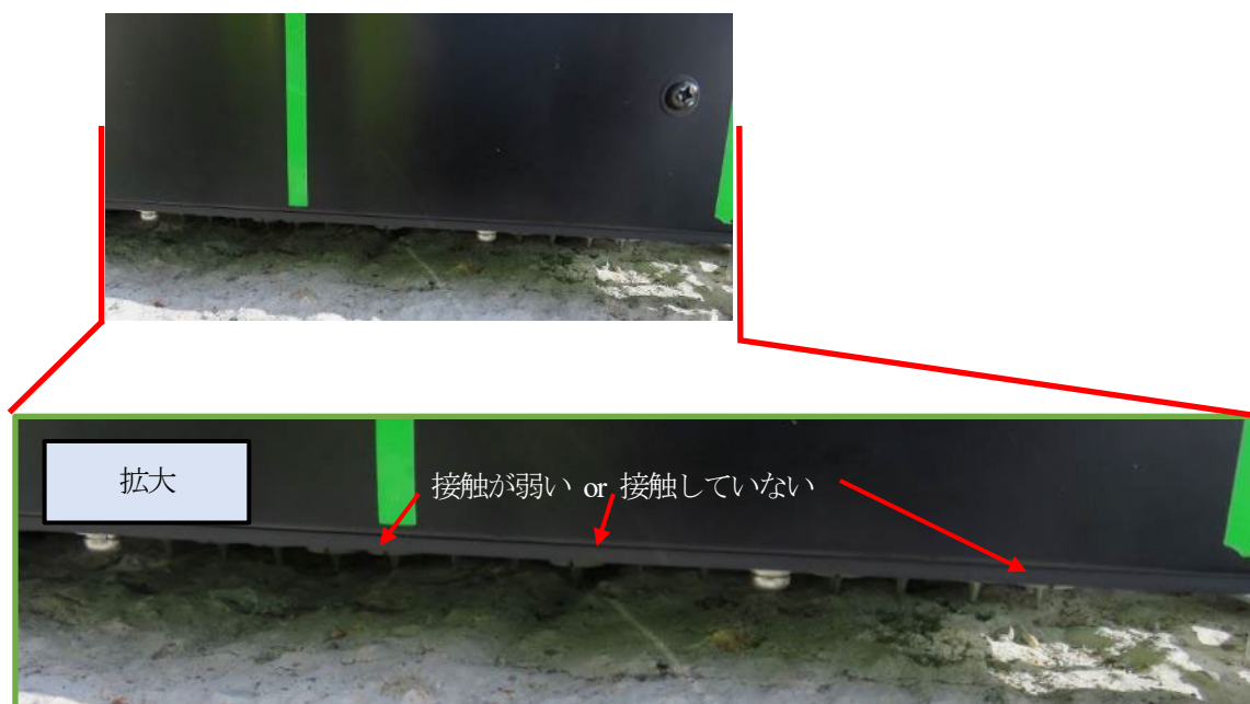
図-5.5.24 撤去床版の表面及びプローブの接触状態
