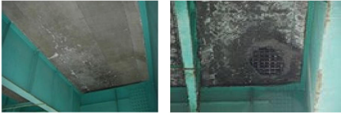
(a) 前回の定期点検時
