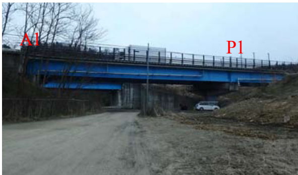
(c) 第1径間 (A1-P1) 全景
