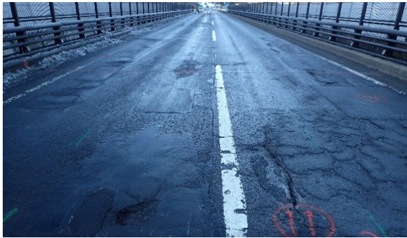
(a) 路面全景 (A1側より撮影)
