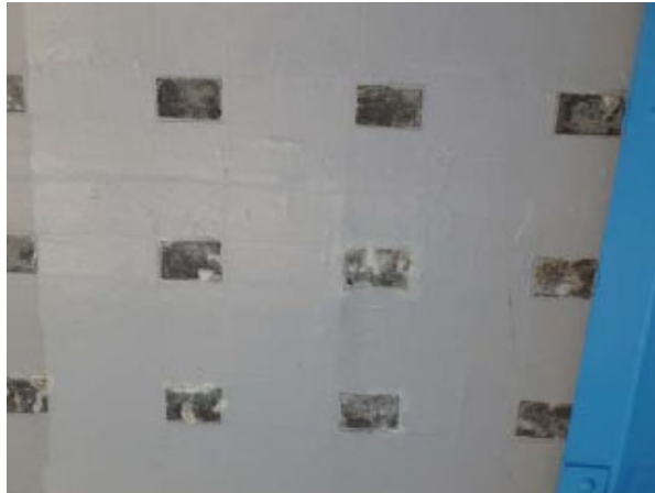
写真-3.1.2 炭素繊維シート貼付け状況
