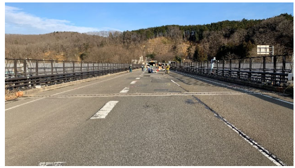
(b) 路面全景 (A2側より撮影)
