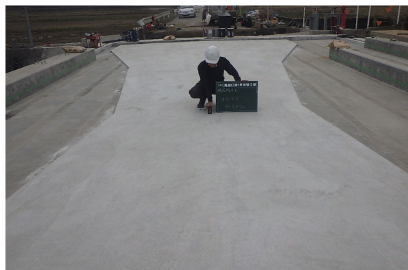
写真-1.1 調整コンクリートの状況
