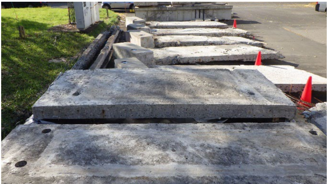
写真-5.1.3 使用した撤去床版
