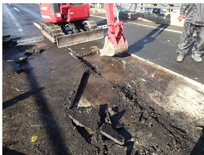
写真4.2.1 舗装開削状況
