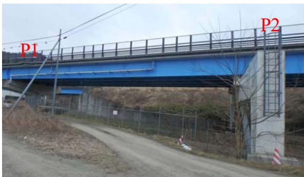
(e) 第2径間 (P1-P2) 全景
