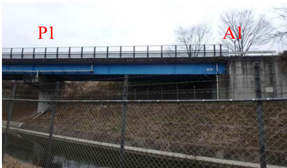
(c) 第1径間 (A1-P1) 全景
