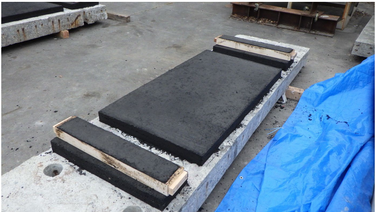
写真-5.1.11 舗装取り外し状況（撤去床版活用供試体 No.2）
