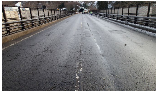
(b) 路面全景 (A2側より撮影)
