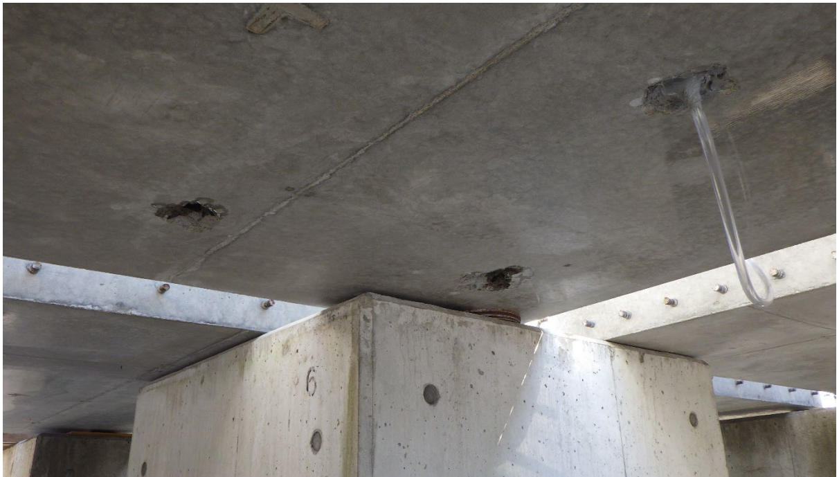
(b) 注水孔と排水孔の下面の状況
