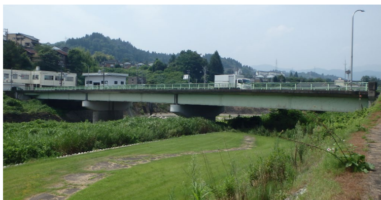
写真-6.3.1 Y 橋 外観写真
