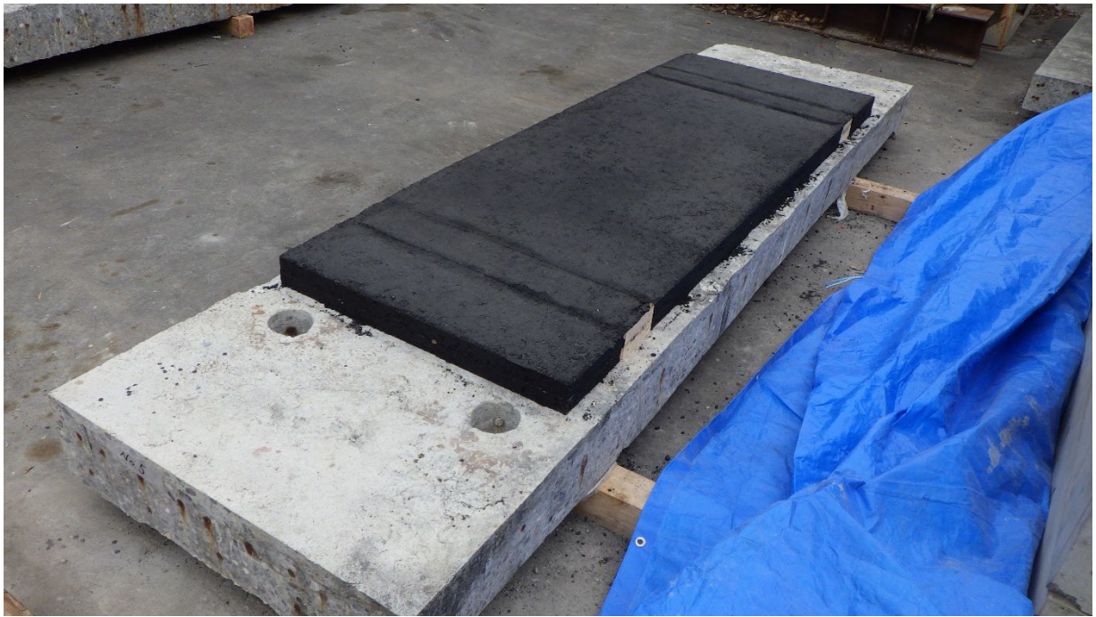
写真-5.1.10 舗装舗設完了状況（撤去床版活用供試体 No.2）
