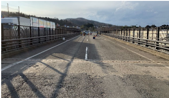
(a) 路面全景 (A1側より撮影)
