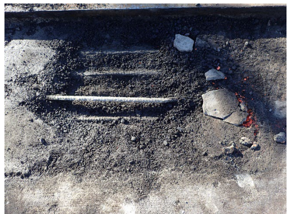
f) 土砂化 (写真3) の赤丸部
