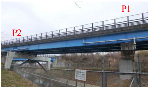
(e) 第2径間 (P1-P2) 全景
