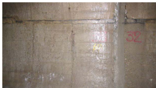
(b) 側壁部の状況
