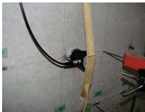
写真-3.1.6 90° 付近での伝播速度測定状況
