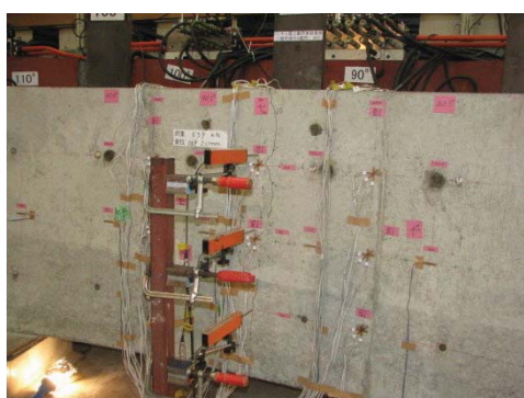
(a) 内面側 90^{\circ} 付近のひび割れ (荷重約 150kN)
