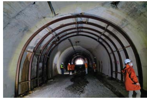
(d) 鋼アーチ補強工 (S096)
