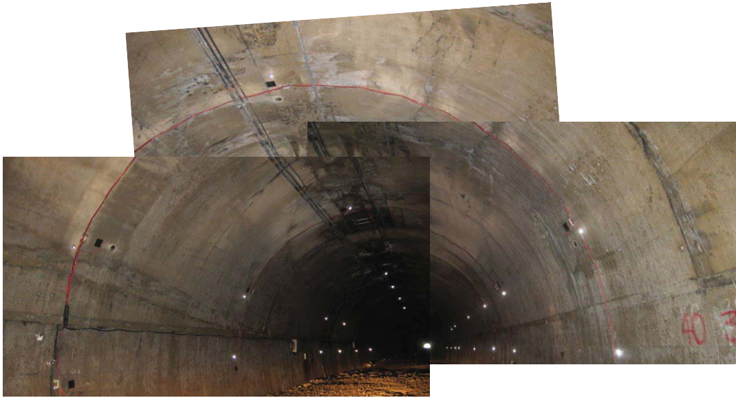
写真-4.1.6 伝播速度を測定した付近のトンネル状況および測定時の状況
