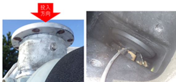
写真-7 内視鏡投入状況 (排気管接続部)
