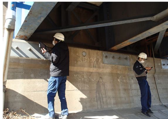
写真-2 現場実証の状況
