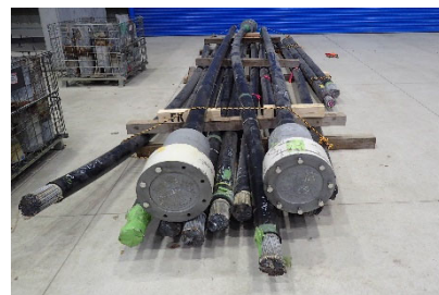
写真-3 撤去ケーブル保管状況
