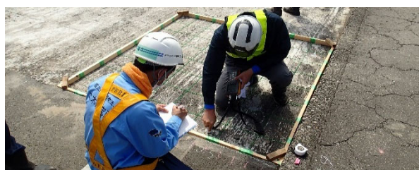
写真-7 床版上面水分量計測状況
