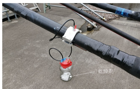
写真-15 乾燥剤による除湿状況
