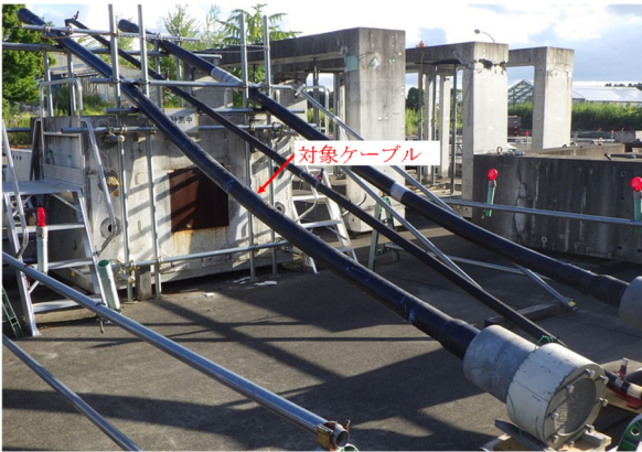
写真-11 ケーブル設置状況
