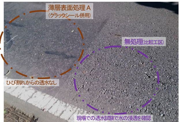
図-12 試験舗装箇所②の路面と透水状況
