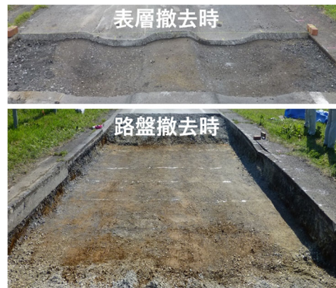
写真-2 開削調査時の舗装状況
