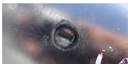
写真-4 削孔時の状況
