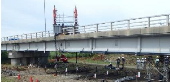
写真-1 本橋全景（実橋載荷試験実施時）
