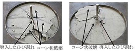
写真-5 母材コンクリートの破壊状況の例 (a) ひび割れ幅 0.2mm 以下 (b) ひび割れ幅 1.0mm
