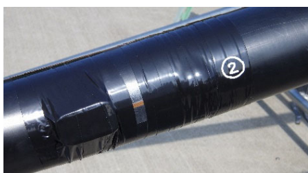
写真-5 温湿度計設置状況 (撤去ケーブル)
