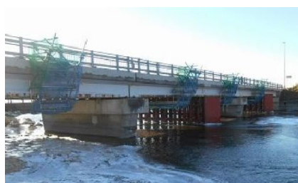
写真-1 対象橋梁全景
