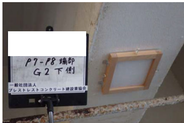
写真 2.5.1 ドライガーゼ法の調査状況 (下フランジ暴露状況)
