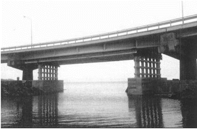
A橋中間支柱の設置後の状況
