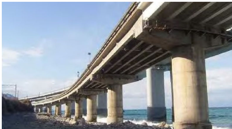
写真 2.3.1 調査橋梁の供用環境
