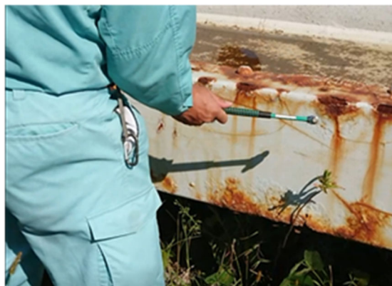
写真 5.3.1 下フランジの打音調査状況
