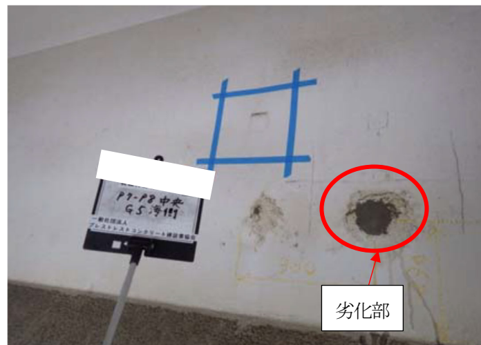
写真 2.4.1 劣化部の例
