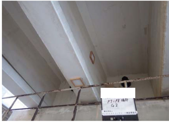
写真 2.5.2 ドライガーゼ法の調査状況（暴露状況全景）
