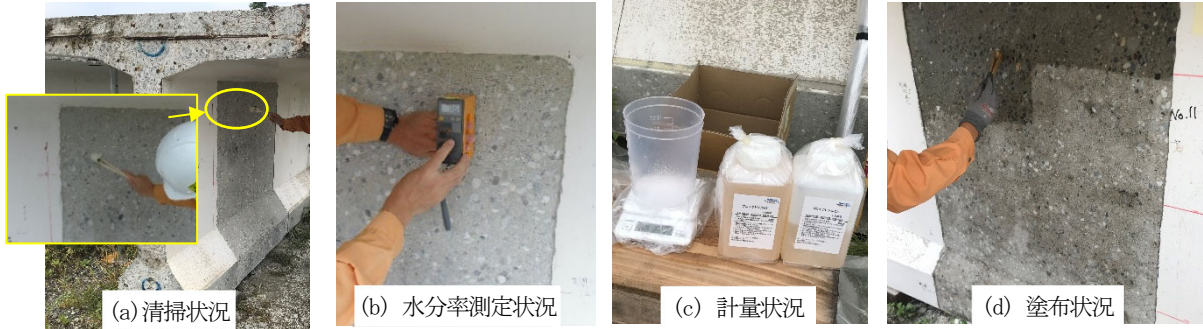
写真 4.3.1 含浸材塗布作業状況
