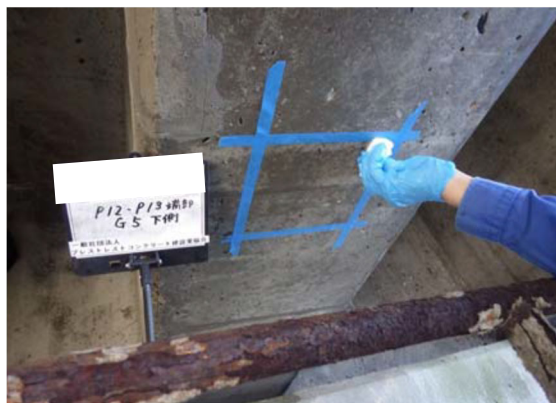
写真 2.5.3 拭き取り法の調査状況（下フランジ拭き取り状況）
