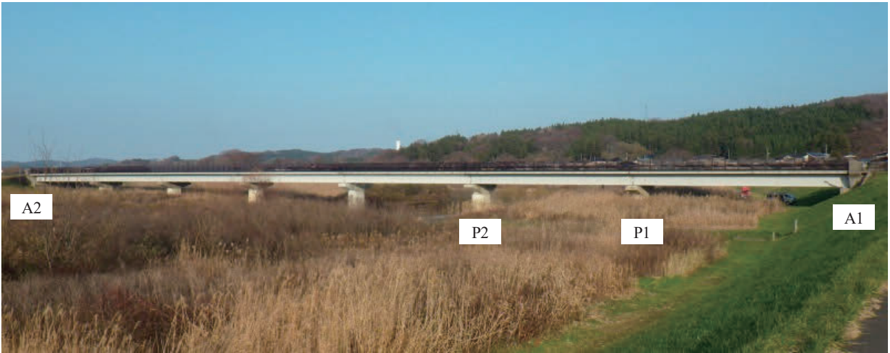
図-3.2.1 対象橋梁の全景
