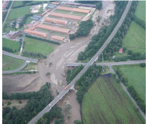
図-6 平成28年8月北海道豪雨による十勝川水系小林川に架かる橋梁被災状況
