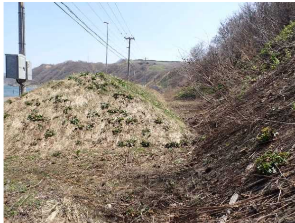
写真-3.1 落石防護土堤・溝
