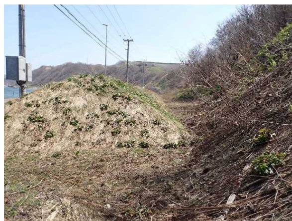
写真-1 落石防護土堤・溝
