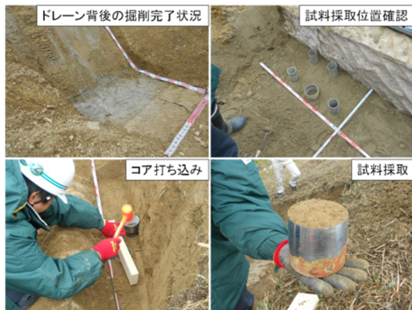
写真-1 土質試料採取状況
