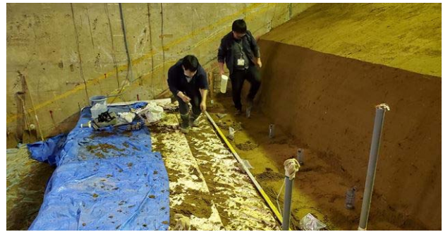
写真-2 開削面での調査状況
