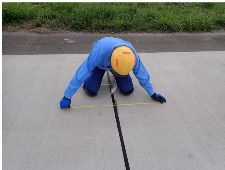
写真-6.2 ダウエルバー上に中心線を描く
