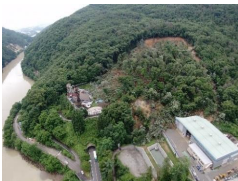
図-3 長野県長野市小松原地区地すべり
