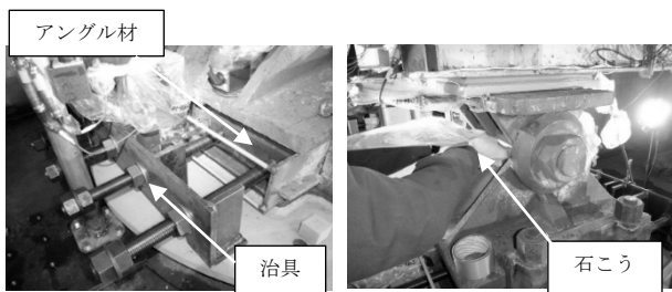
(a) 水平変位の拘束 (b) 回転変位の拘束 写真-2 ピンローラー支承の拘束状況
