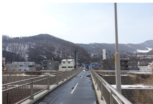
写真-1 景観色が使用された土木施設 (札幌市内/グレーベージュ)
