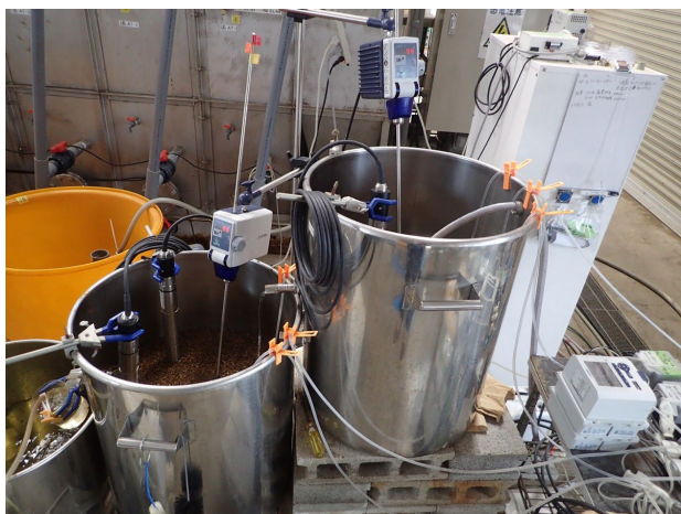
写真-3 NH 4 -N と医薬品除去実験に用いた流動型担体処理装置
