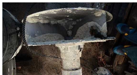
写真 10 水流生成装置吐出部の実験後状況
