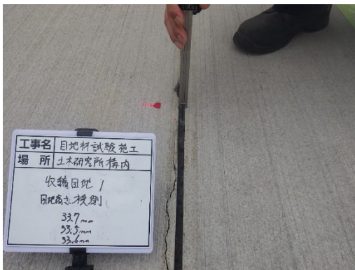
写真- 5.5.5 目地高さ検測
