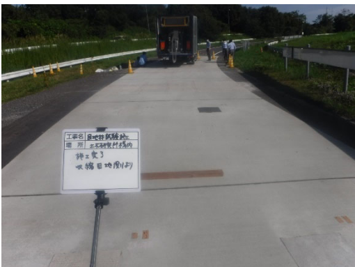
写真- 5.5.13 施工完了 収縮目地側より
