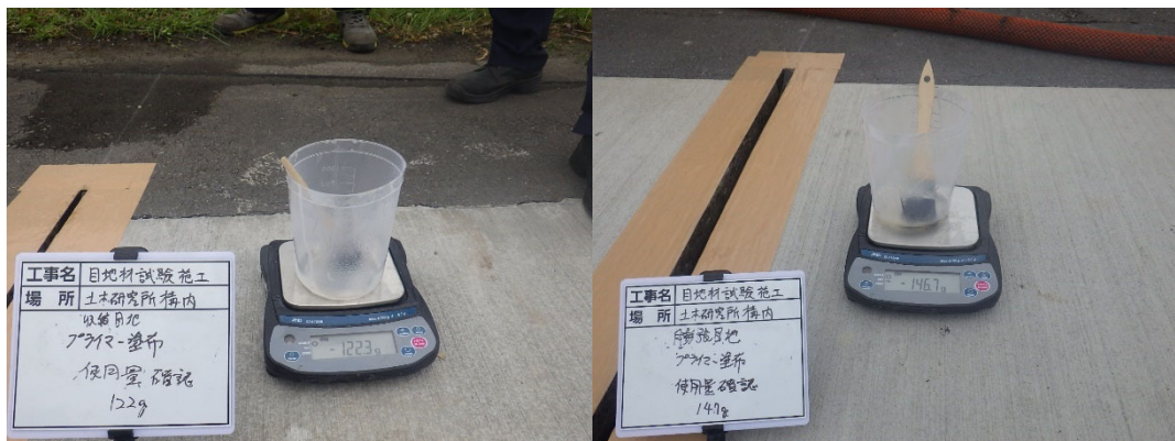
写真- 5.7.1 プライマ使用量の確認
