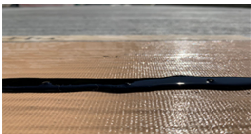
写真- 6.4.5 余盛り注入状況 (計3回注入後)
