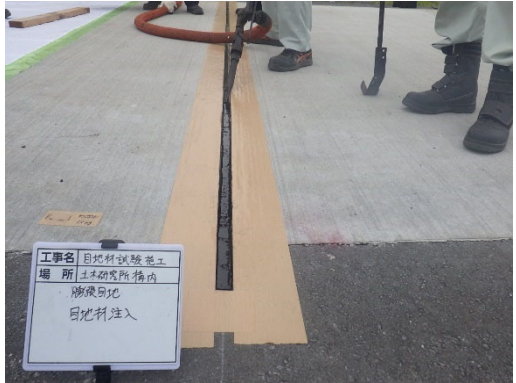
写真- 5.5.10 目地材注入状況 2
