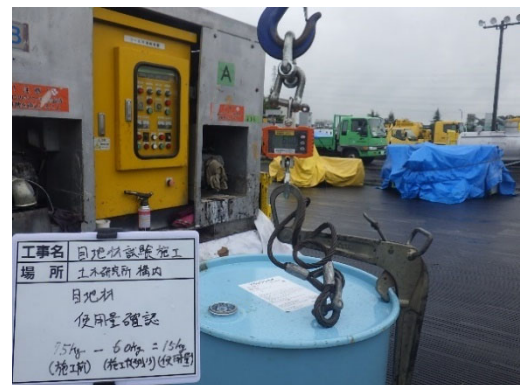
写真- 5.7.2 目地材使用量の確認
