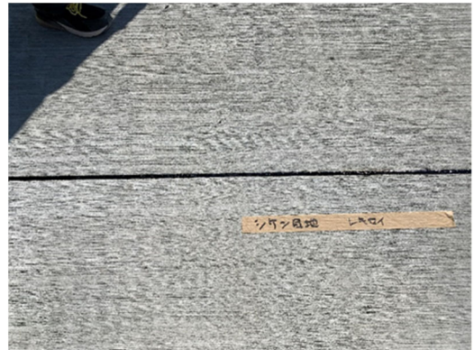
写真- 6.4.9 瀝青目地仕上がり状況 (断面①)
