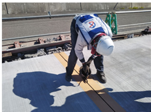
写真- 6.4.4 注入状況 (やかんで注入 (計3回) )
