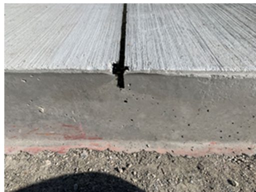
写真- 6.4.19 瀝青目地仕上がり状況 (断面②) ※誘導ひび割れなし
