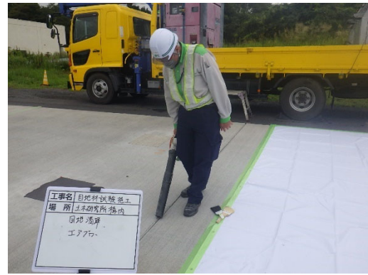
写真- 5.5.4 目地清掃2 エアブロー
