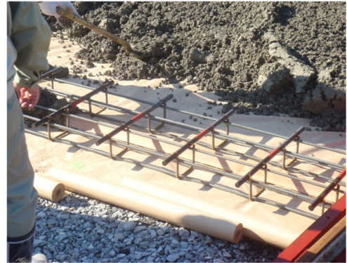
写真-4.3.1 ダウエルバーの状況
