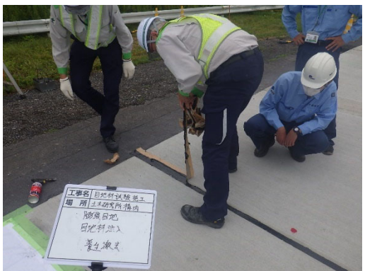
写真- 5.5.12 養生撤去
