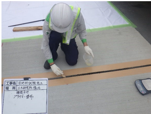
写真- 5.5.7 プライマ塗布状況
