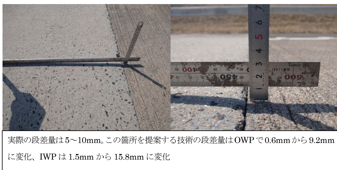
写真- 6.2.1 検証箇所の状況
