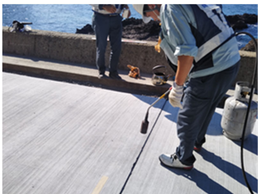
写真- 6.4.7 仕上げバーナー (表面をなじませる)
