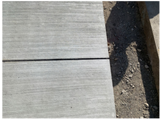
写真- 6.4.11 瀝青目地仕上がり状況 (断面①)
