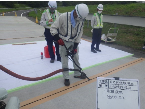
写真- 5.5.9 目地材注入状況 1
