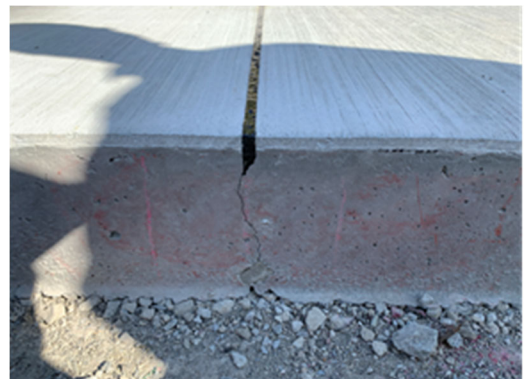
写真- 6.4.13 瀝青目地仕上がり状況 (断面①) ※誘導ひび割れあり
