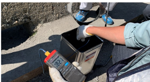
写真- 6.4.3 目地材加熱 (180°C~200°Cに加熱)
