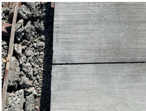
写真- 6.4.14 瀝青目地仕上がり状況 (断面②)
