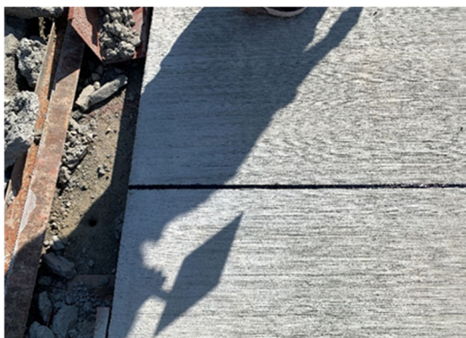
写真- 6.4.12 瀝青目地仕上がり状況 (断面①)
