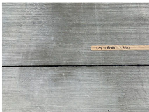
写真- 6.4.16 瀝青目地仕上がり状況 (断面②)
