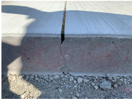
写真- 6.4.10 改質瀝青系仕上がり状況
