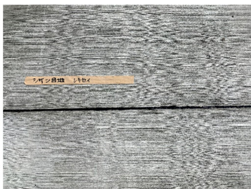
写真- 6.4.18 瀝青目地仕上がり状況 (断面②)
