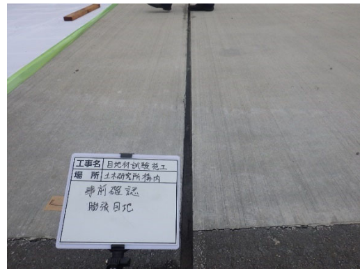
写真- 5.5.2 事前確認 膨張目地
