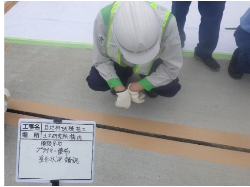
写真- 5.5.8 プライマ塗布状況の確認
