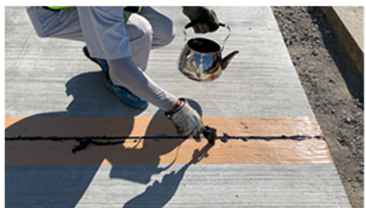
写真- 6.4.6 表面整形 (加熱した鉄バテで余盛カット)
