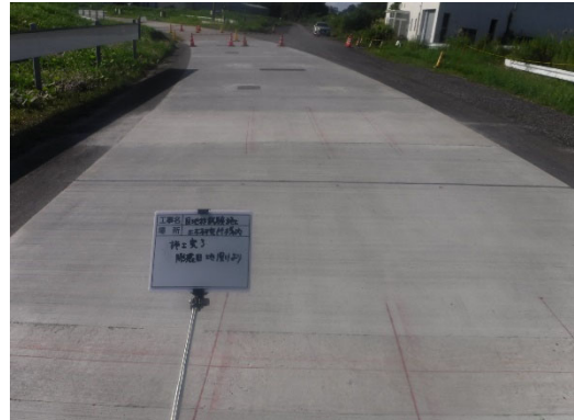
写真- 5.5.14 施工完了 膨張目地側より
