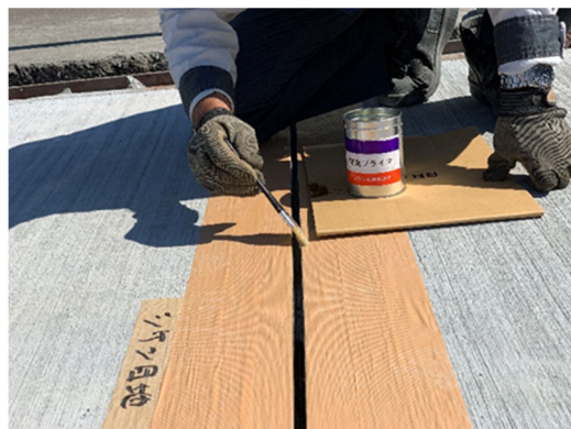
写真- 6.4.2 プライマ塗布状況 (30分程度で乾燥)
