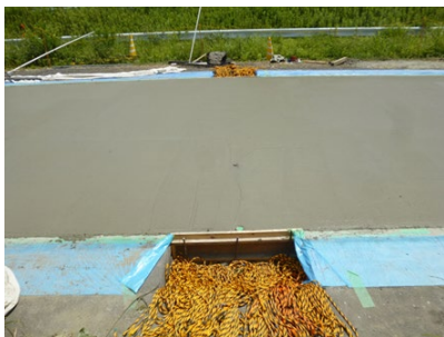
④ コンクリート版打設
