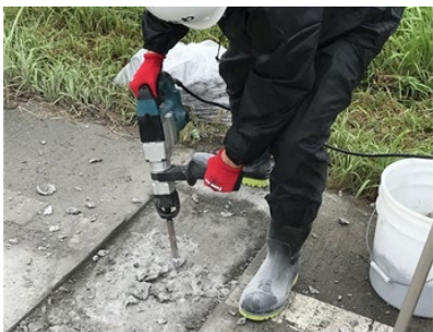
①補修箇所の研り
