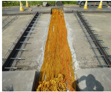
② トラロープ設置
