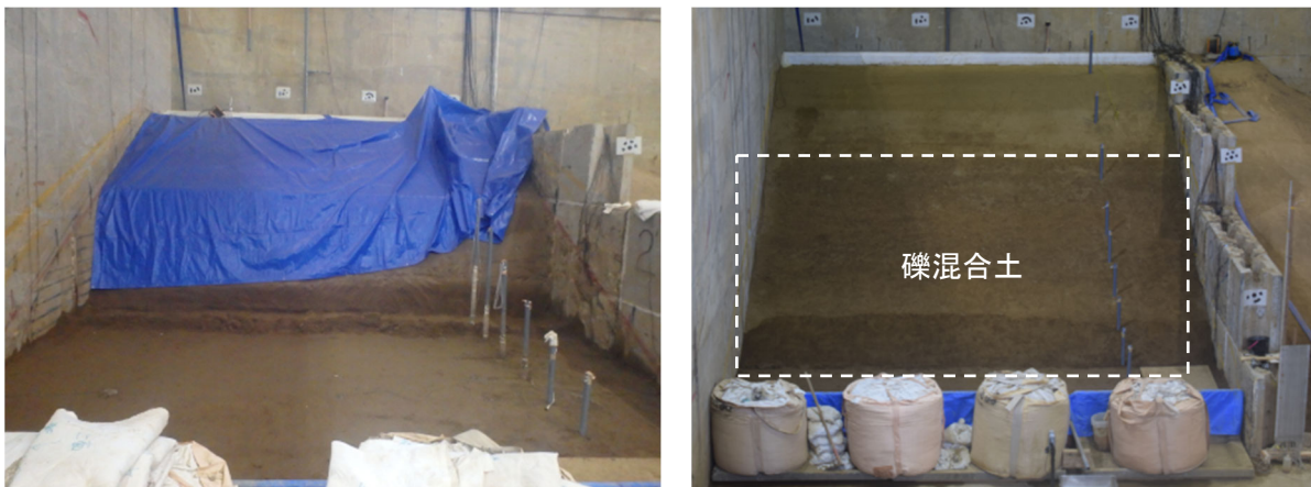
図 3.4.8 左：ドレーン工撤去状況、右：完成後模型状況
