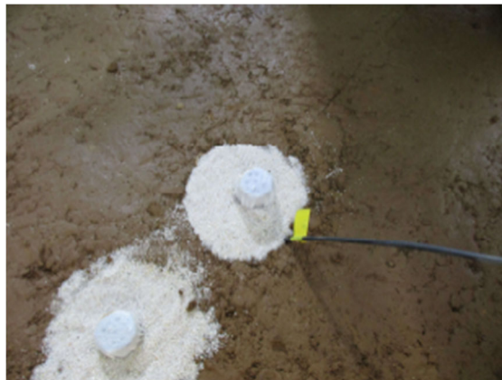
図 2.4.26 左：間隙水圧計設置状況
