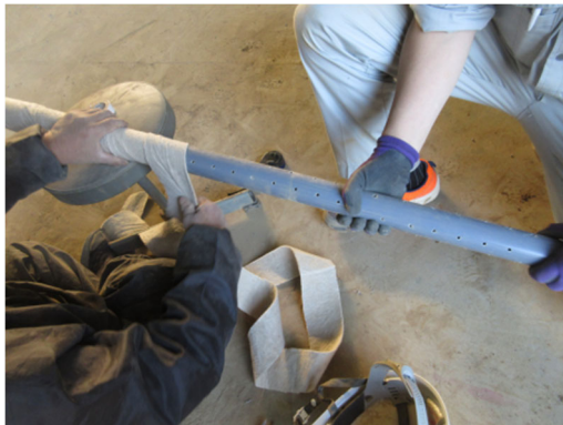
図 3.4.15 左：水位観測孔作製状況、右：水位観測孔設置状況
