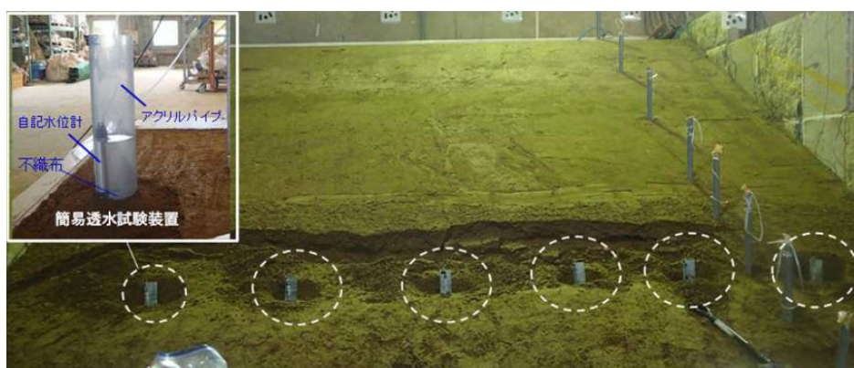
図 3.4.20 簡易透水試験実施状況
