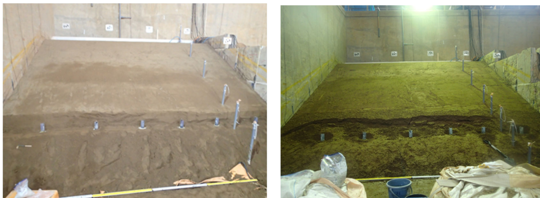
図 3.5.39 簡易透水試験実施状況
