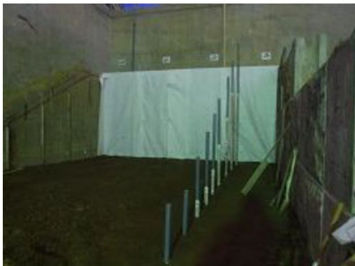
図 3.4.16 左：水位観測孔設置状況全景、右：使用水位計
