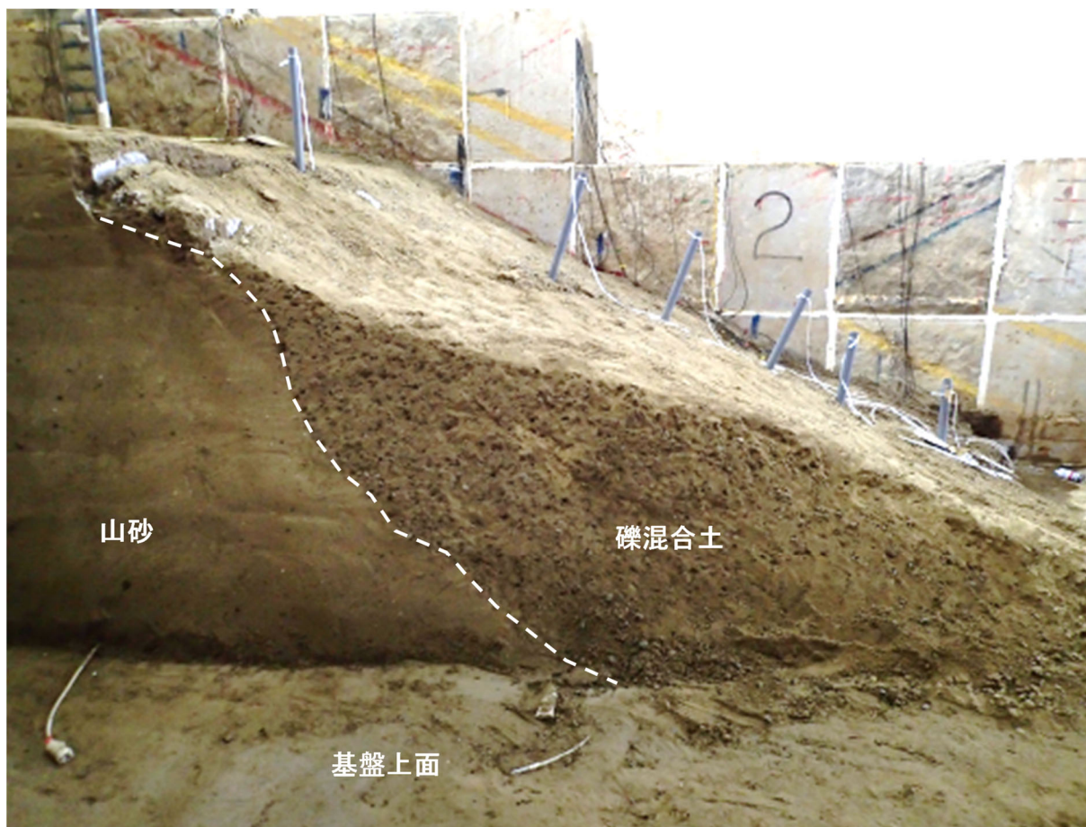
図 3.5.80 開削断面の状況（破線は山砂と礫混合土の境界部）
