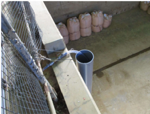
图 2.4.3 外部排水槽構築状況
