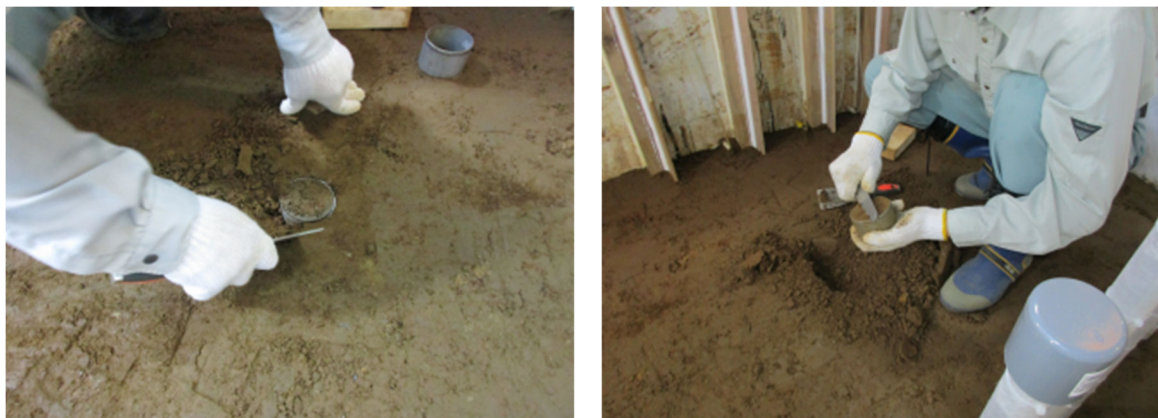
図 2.4.21 密度管理作業状況（コアカッター法）
