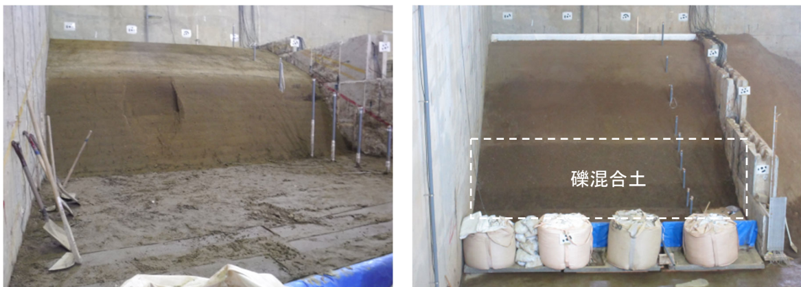
図 3.4.4 左：崩壊部付近解体状況、右：完成後模型状況
