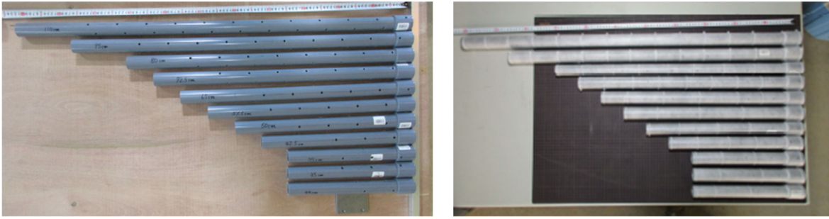
図 2.4.28 ストレーナー管加工状況
