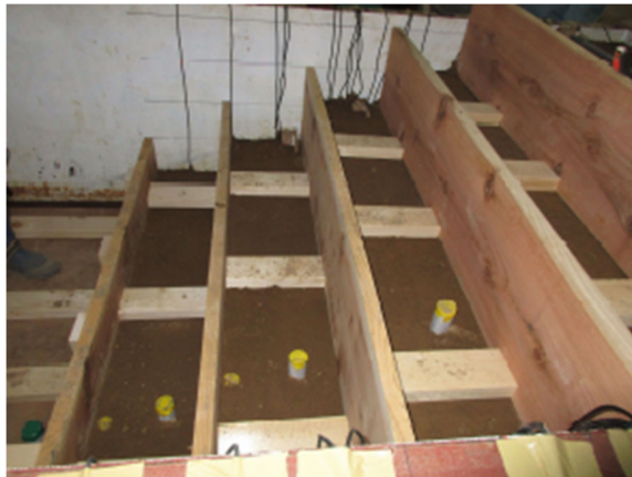
図 2.4.6 左：木製型枠設置・盛土状況 1、右：木製型枠設置・盛土状況 2
