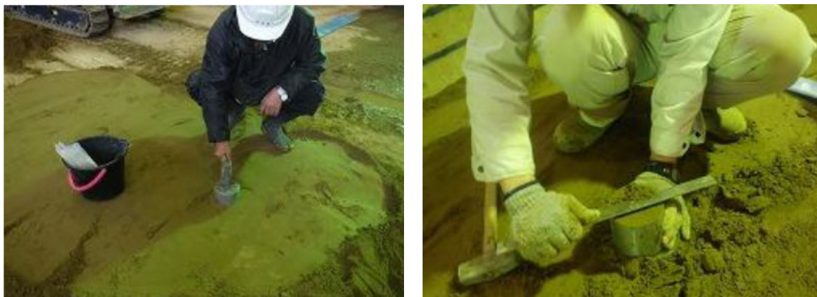
図 3.4.9 密度管理作業状況（コアカッター法）
