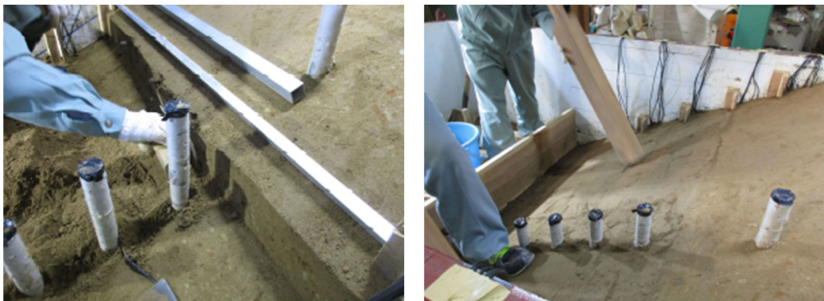
図 2.4.13 左：置換範囲掘削状況、右：礫混合土置換範囲作製状況
