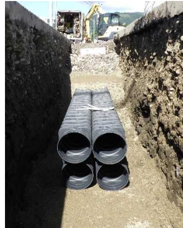
写真-2.11 掘削断面の仕上がり精度と管路積み上げ状況
