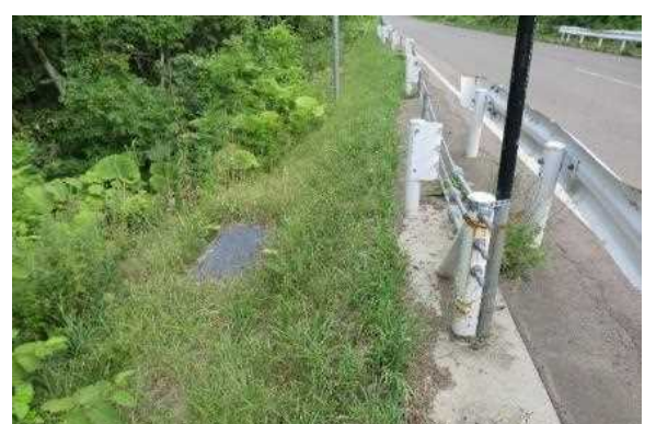
写真-2.10 車道法面部に設置した特殊部
