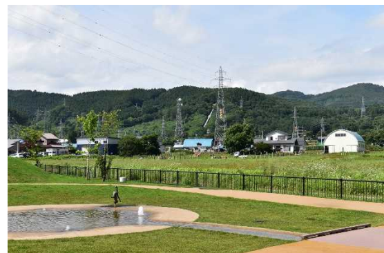
写真-4.5 自然景観における送電鉄塔
