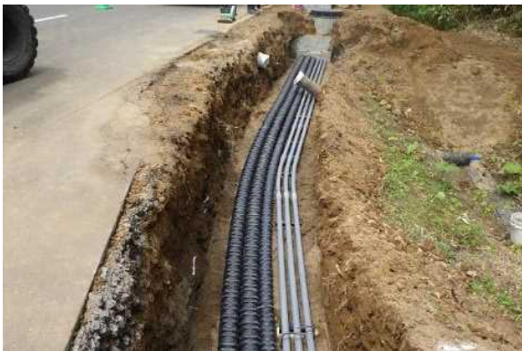
写真-2.7 法面部の床堀状況
