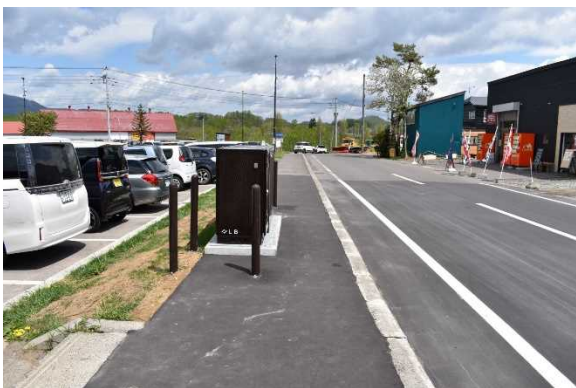
写真-2.5 歩行者の通行幅が確保できていない事例
