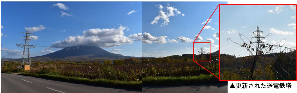
写真-4.12 既設分岐から変電所までは1→2回線に増強され、大型の送電鉄塔へ建て替えられた
