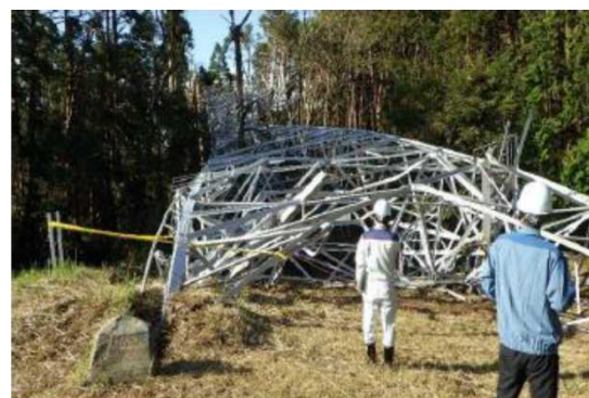
写真-4.4 令和元年台風15号による送電鉄塔の倒壊（千葉県）
