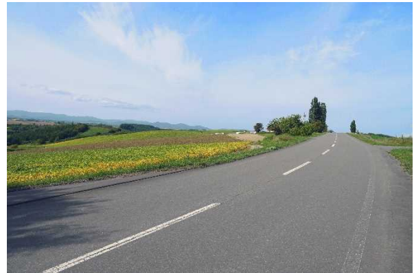
写真-1.2 新栄の丘展望公園近傍の電線類地中化事例
