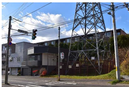
写真-4.3 宅地建物に隣接する高圧送電鉄塔（札幌市）
