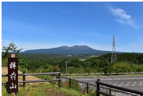
写真-4.1 樽前山の景観を阻害する高圧鉄塔／送電線
