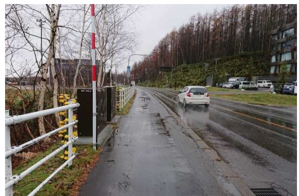
写真-3.4 歩道外に設置し安全性やメンテナンス性が向上
