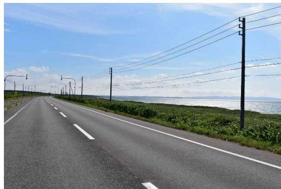
写真-2.1 地中化ニーズの高い郊外部の道路
