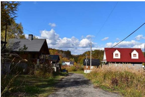
写真-4.10 既設の架空線が撤去された区間
