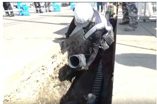
写真-2.12 角形多条電線管の敷設状況
