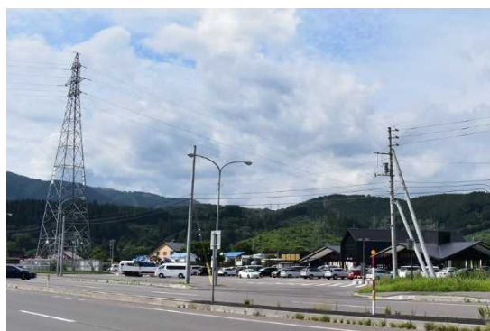
写真-4.2 「道の駅」なないろ・ななえ前の無電柱化区間と高圧鉄塔／送電線
