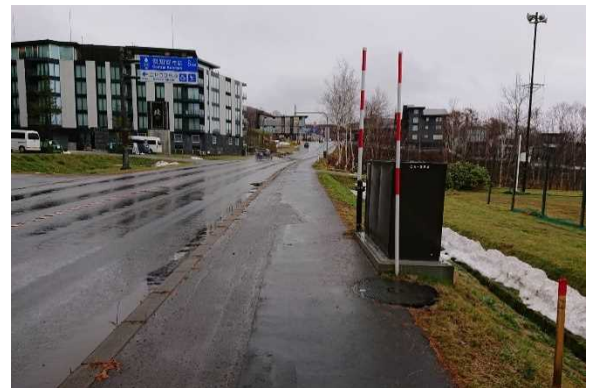
写真-2.6 歩行者の通行幅や安全性を考慮した埋設位置
