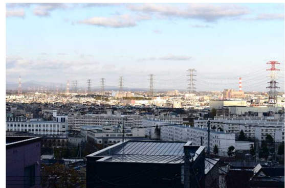
写真-4.8 市街地における27万5000V送電線 (札幌市)
