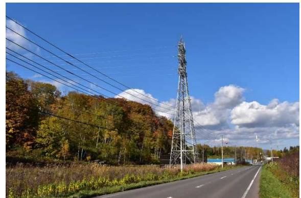
写真-4.11 移設ルートの新設送電鉄塔 (架空線～地中線の切り替え点)
