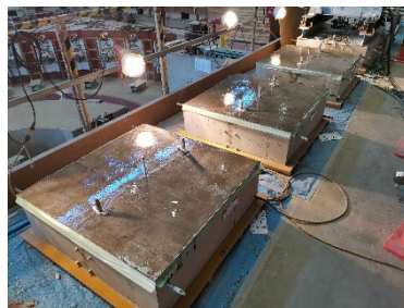
下地材の塗布
