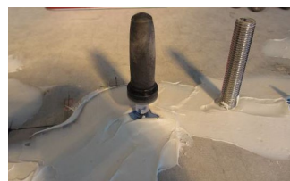
(b) インジェクターによる 注入材の注入
