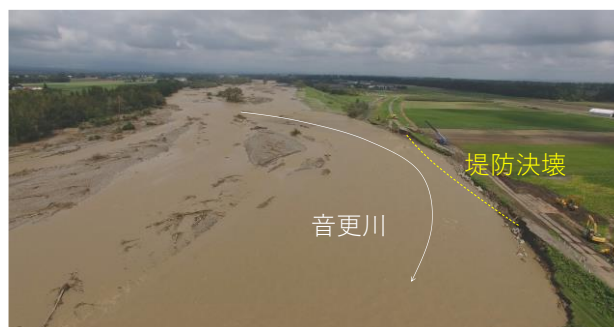
写真-2 音更川 KP21.2 で発生した堤防決壊 (2016年出水、帯広開発建設部提供)
