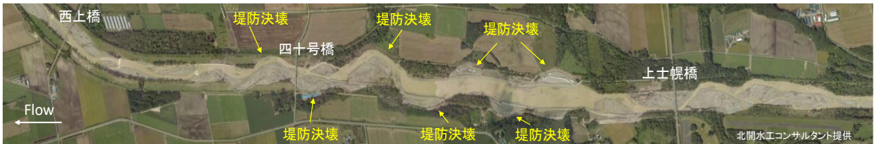
図-9 出水後の河道状況
