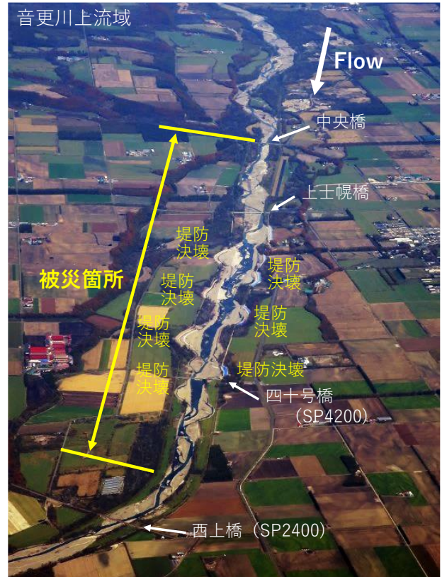
写真-3 音更川上流部で連続して発生した堤防決壊 5)
