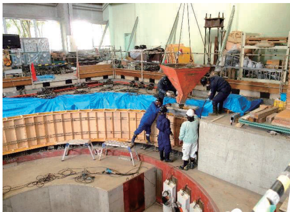
(a) 普通コンクリートの打設
