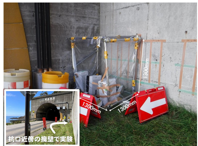
写真-6 試験施工の様子（増毛、コンクリート面に布テープを貼って仕切った枠内がシラン系表面含浸材塗布範囲）
