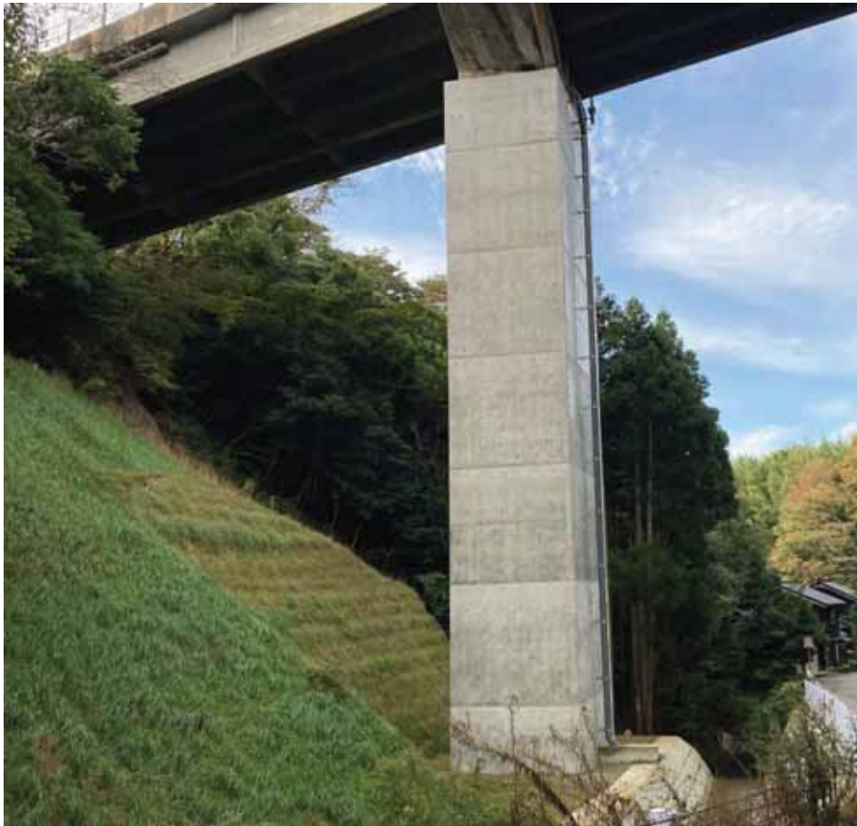
写真 4-9-3 水路と法面に挟まれた高橋脚の矩形柱
