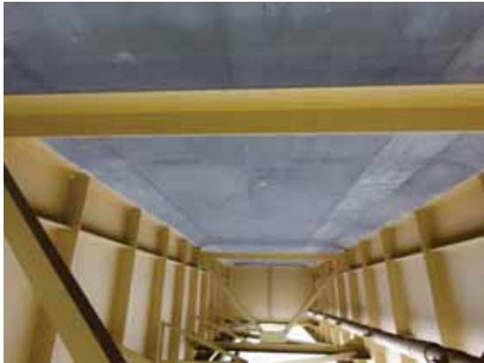
桁間へのアプローチ状況
