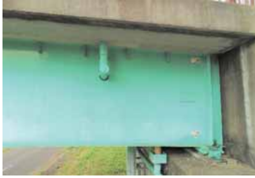
支承・桁の取得画像
