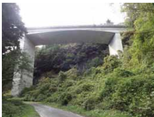
a) 高架下に高所作業車設置困難な例
