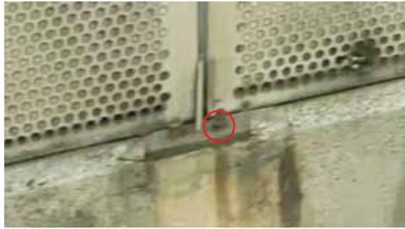
ナット欠損（シングルナット）
