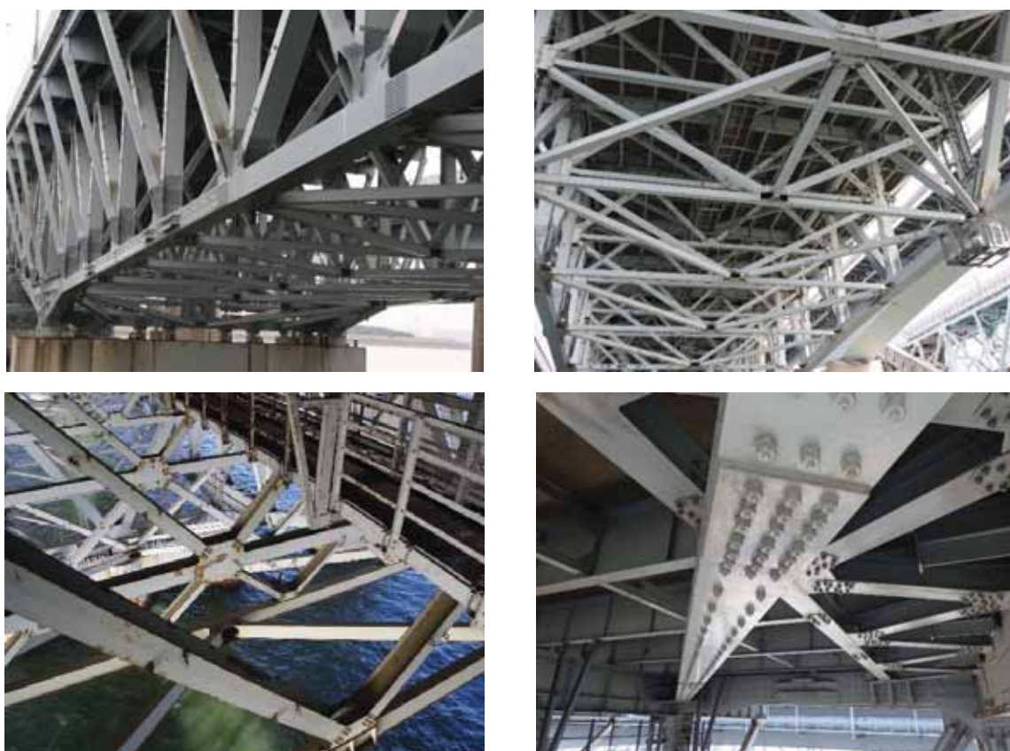
トラス橋（入り組んだ部材で近接困難）
