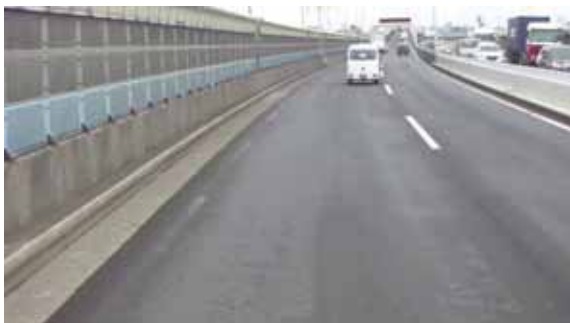
コンクリート高欄上に設置された遮音壁
