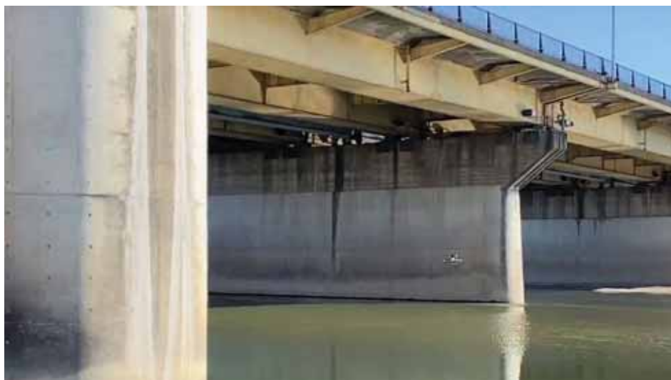
写真 4-9-1 河川内橋脚（小判型柱）実施例
