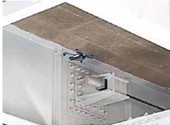
桁間へのアプローチ状況
