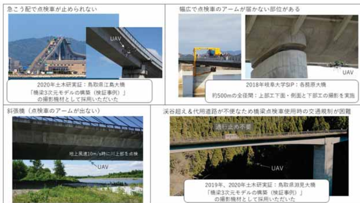
図 4-11-14 点検支援した橋梁の例
