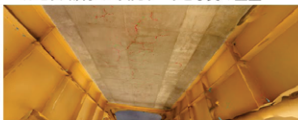
3次元データとひび割れ抽出後の床版画像重畳
