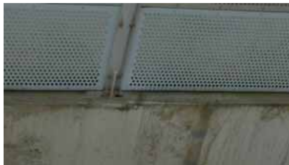
遮音壁基部の撮影例
