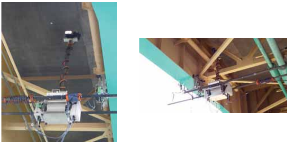
写真 4-3-2 Turrets による撮影の様子
