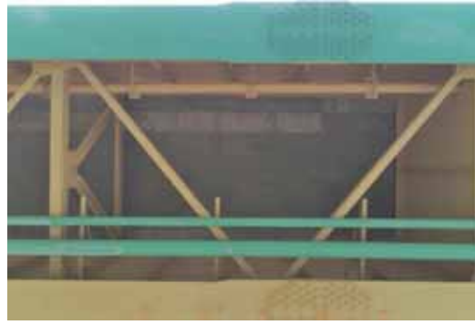
支承・桁の取得画像
