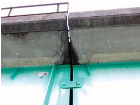
桁端部へのアプローチ状況
