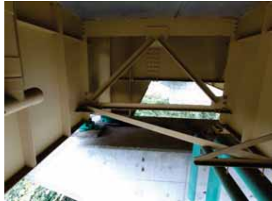
橋脚天端支承部へのアプローチ状況
