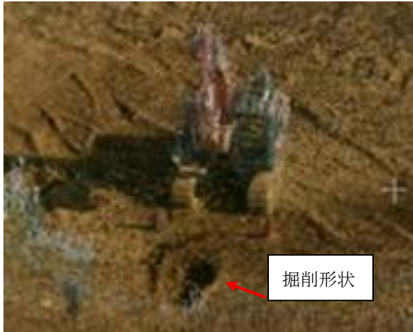
Fig. 3.1-1 実環における掘削後の地形形状 3次元点群データ
