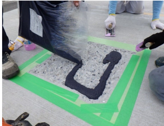
写真-4.4.4 ハイパークールパッチの施工状況
