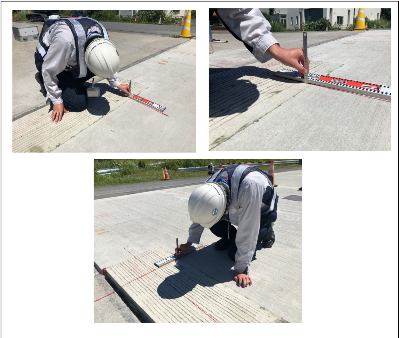
写真-4.7.8 段差測定状況
