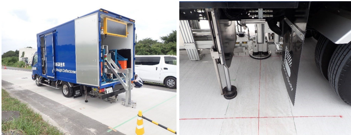
写真-4. 7. 6 FWD 測定状況
