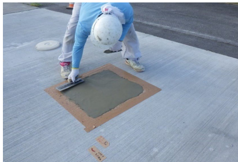
写真-4.4.5 早強モルタルの施工状況
