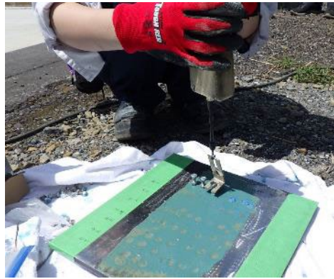
写真-4.4.1 ナット引張試験状況
