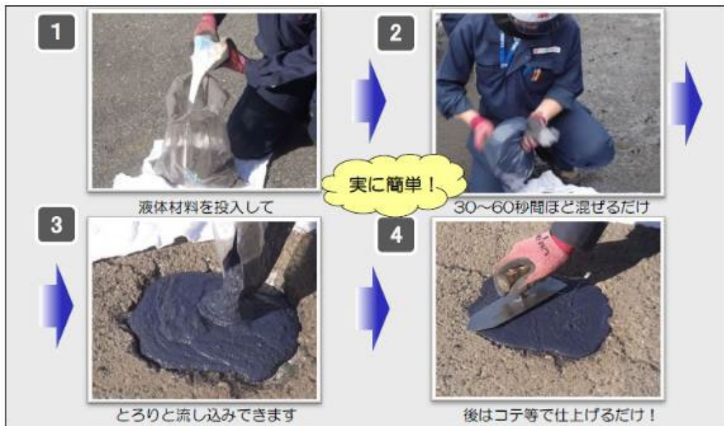
図-2.2.3 ハイパークールパッチ施工方法 (カタログより)
