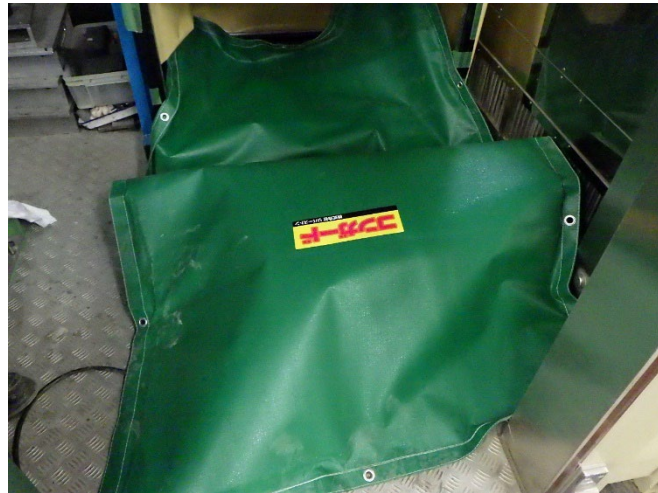
写真-3.1.21 給熱養生状況 (コンガード)
