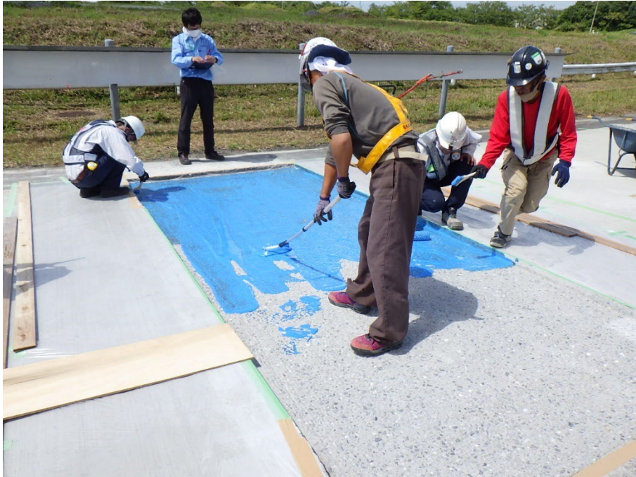
写真-2.2.1 KS ボンドの塗布状況
