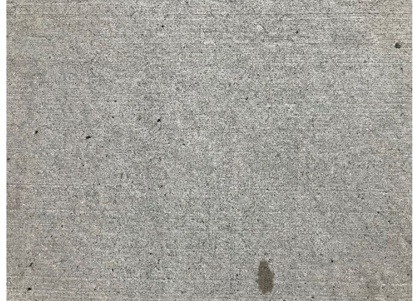
写真-4.3.14 路面のほうき目の状態（左：荷重車走行前，右：211万輪走行後）
