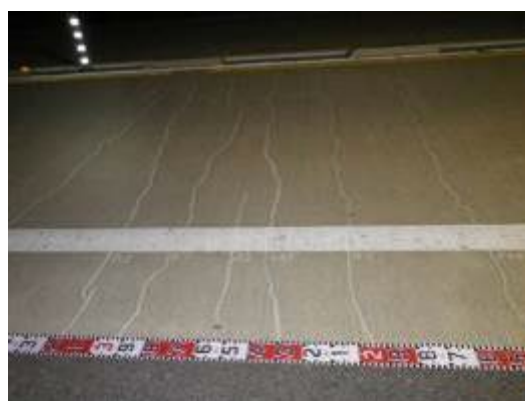
図-2.2.1 ひび割れ調査のイメージ
