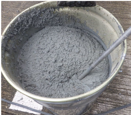
写真-4.3.4 PCMの練り混ぜ状況
