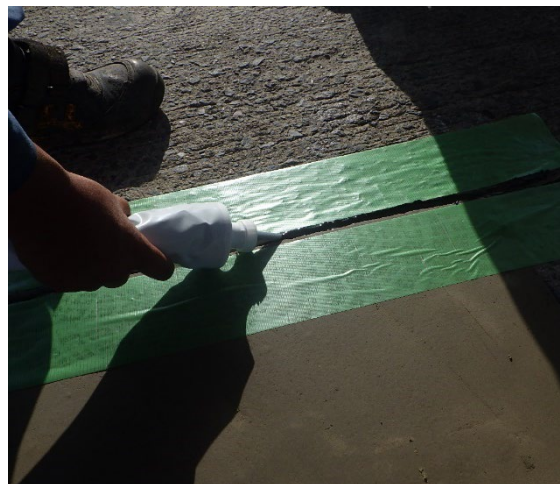
写真-4.3.7 目地材注入状況
