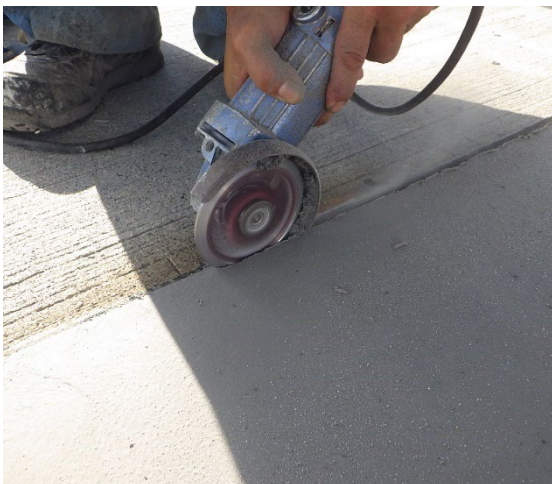
写真-4.3.6 目地切削状況
