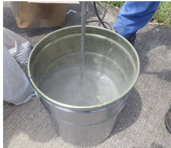
写真-4.3.5 PCM-Fの練り混ぜ状況
