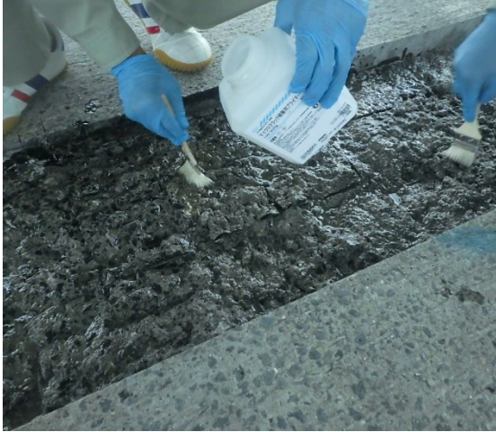
写真-4.3.2 プライマ塗布状況
