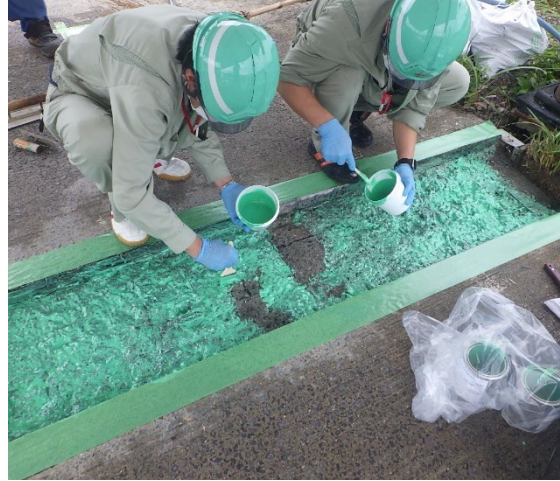
写真-4.3.3 接着剤塗布状況
