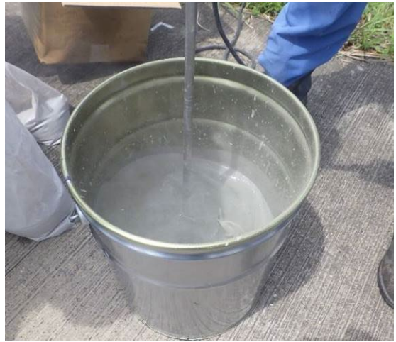
写真-4.3.5 PCM-bの練り混ぜ状況
