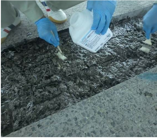
写真-4.3.2 プライマー塗布状況
