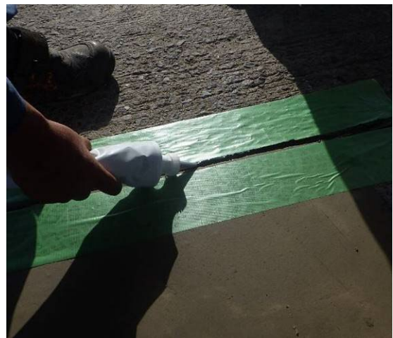
写真-4.3.7 目地材注入状況
