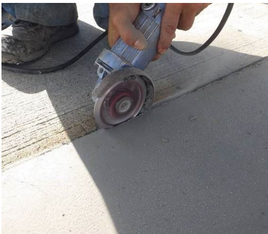
写真-4.3.6 目地切削状況
