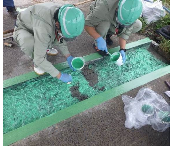
写真-4.3.3 接着剤塗布状況
