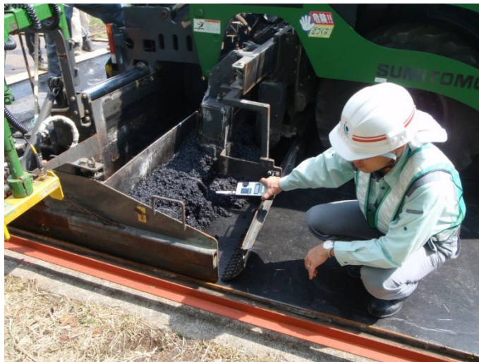
写真-4.5.8 臭気測定状況 (スクリード前)
