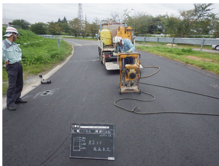
写真-4.5.26 切取供試体採取状況
