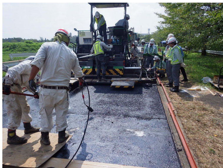
写真-4.5.4 敷均し状況
