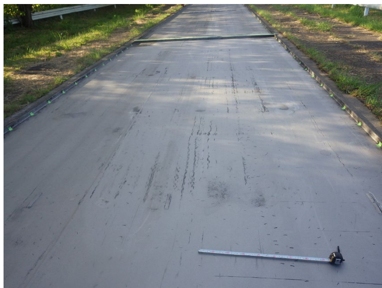
写真-4.5.1 鋼床版面（切削・1種ケレン完了後）
