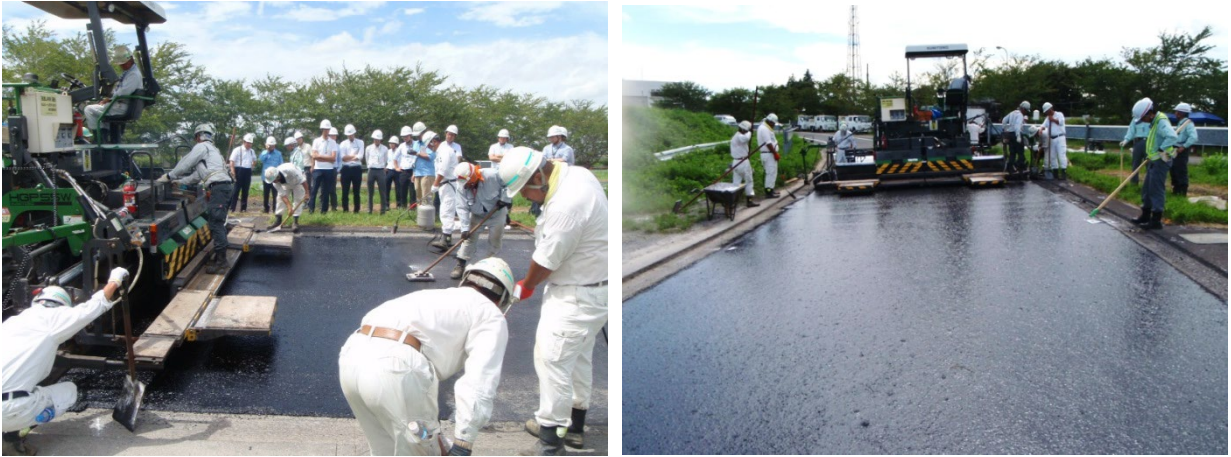
写真-4.5.19 敷均し状況
