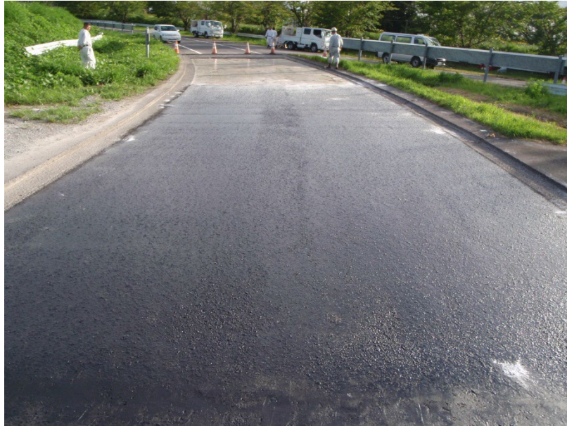
写真-4.5.22 敷均し完了
