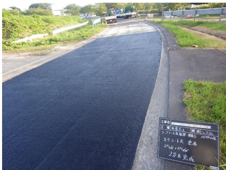
写真-4.5.18 施工前（接着層完了面）
