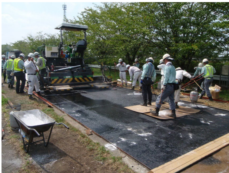
写真-4.5.5 敷均し状況
