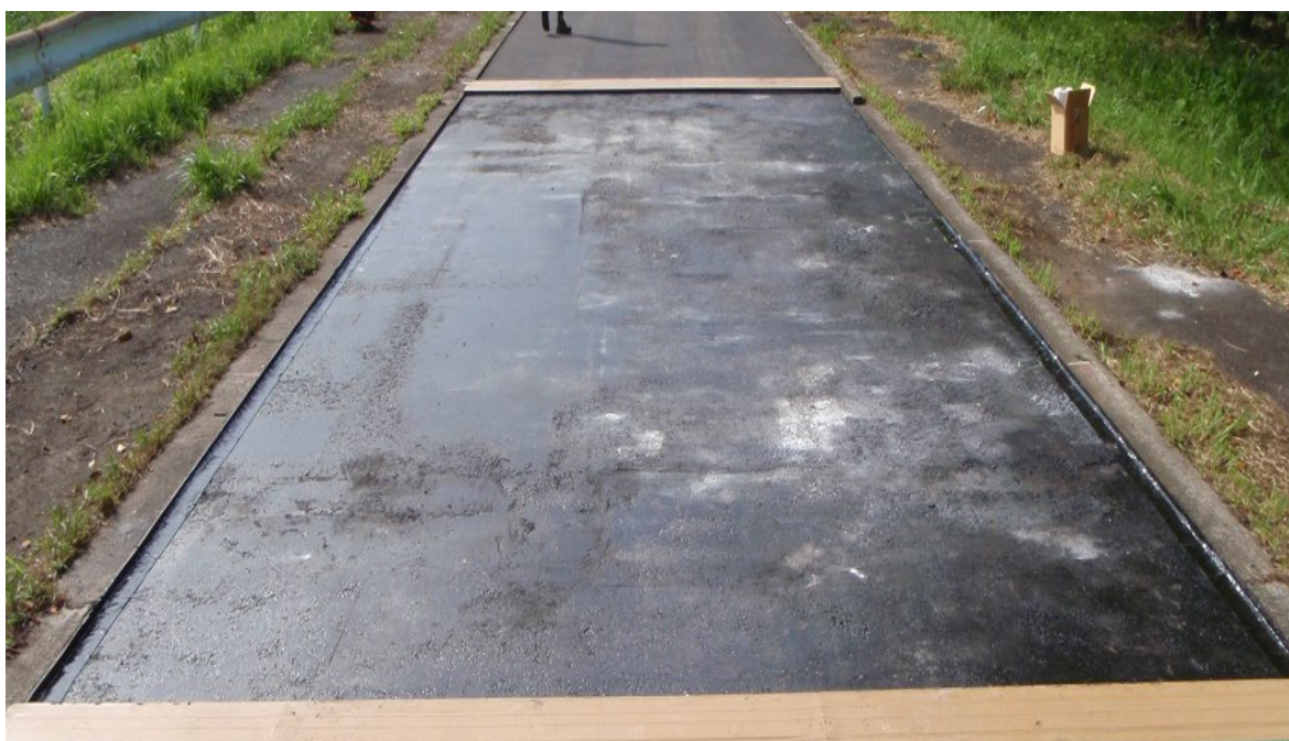
写真-4.5.6 敷均し完了
