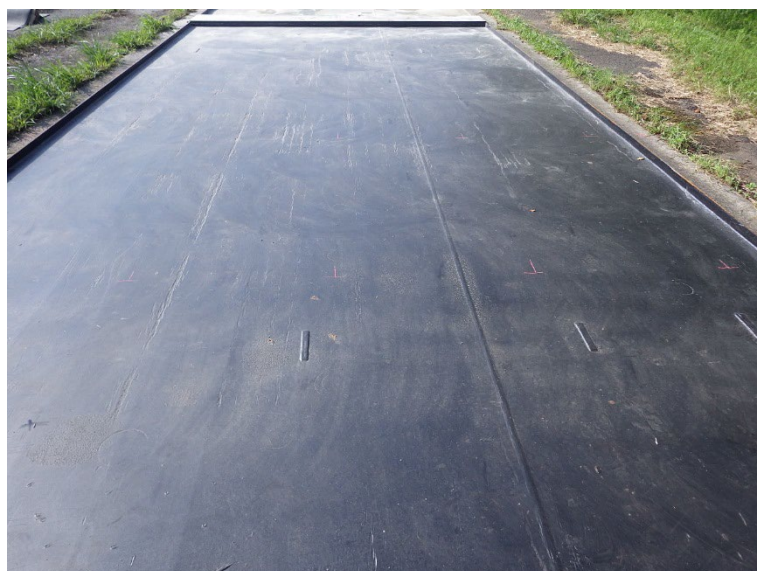
写真-4.5.2 施工前（接着層完了面）
