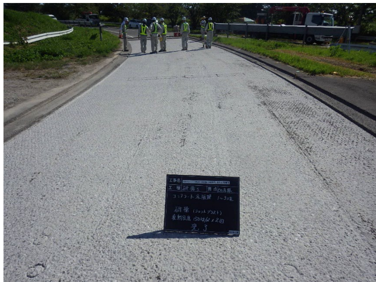
写真-4.5.17 施工前（切削・表面処理面）
