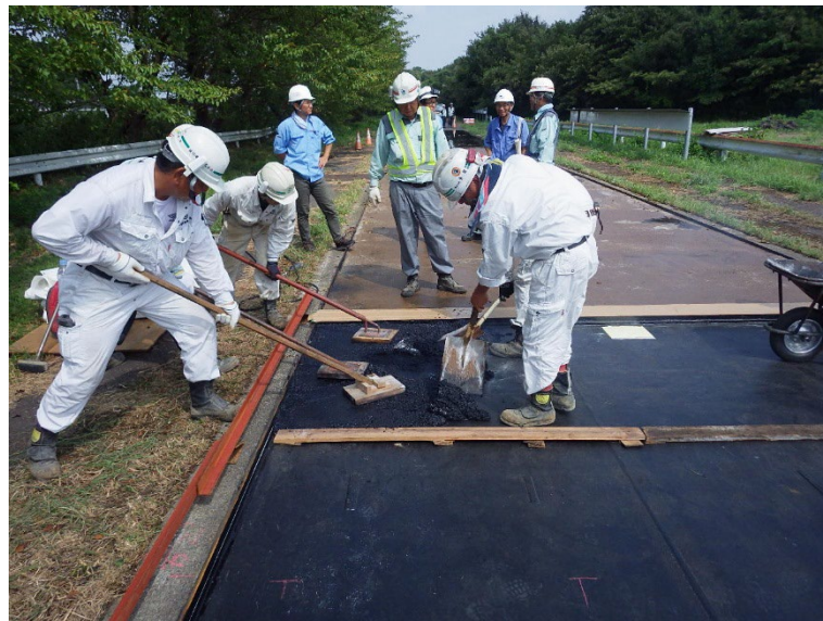
写真-4.5.3 施工起点部人力敷均し状況
