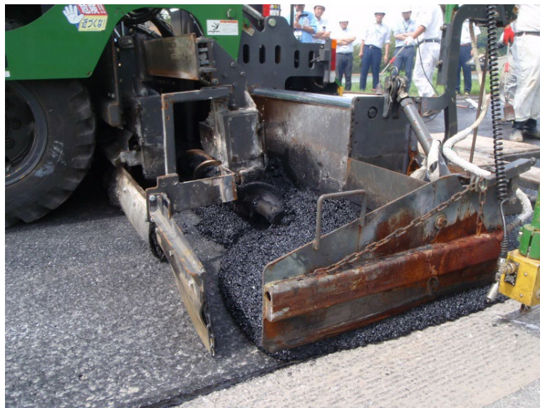
写真-4.5.20 敷均し状況
