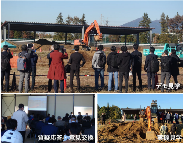
図-4 自律施工デモンストレーションの様子 についても汎用ライブラリである move_base や pid 等 が活用されている。
