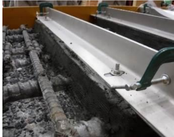
写真-4.4.2 ひび割れ誘発目地の設置状況
