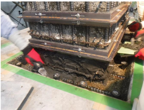
写真-4.4.38 ベースプレートの施工
