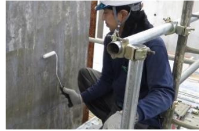
(3) プライマー塗布
