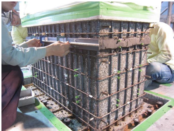
写真-4.4.37 土台コンクリート、目地材の設置
