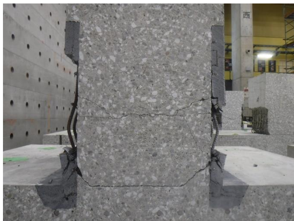
写真-4.4.89 No.2 切断面の状況
