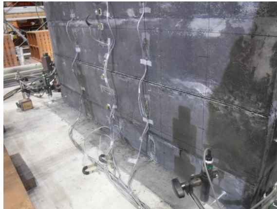
写真-4. 4. 48 補強部のはらみ出し状況(No.2 限界状態 2)
