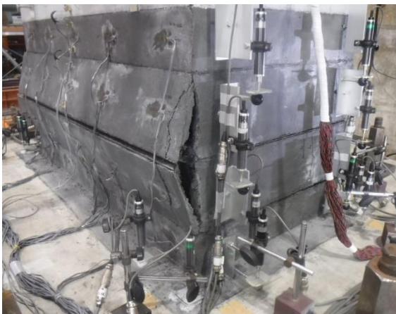
写真-4.4.45 +6\delta_y 3 回目 圧縮側柱基部
