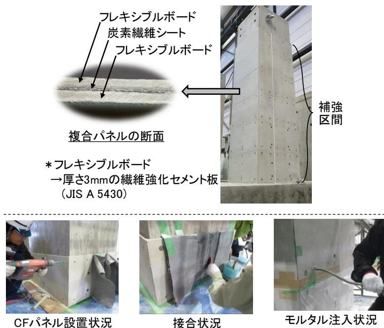
図-5.2.3 CF パネル工法の概要
