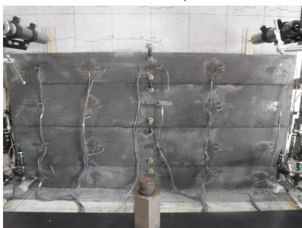
写真-4.4.79 +5δ, (限界状態 2) 圧縮側 基部から 3 段目の補強部に縦方向のひび割れ
