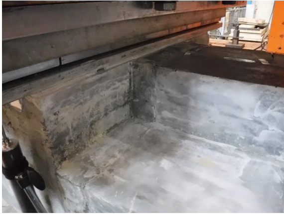
写真-4.4.20 荷重版付近の状況
