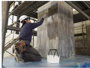
② プライマー塗布
