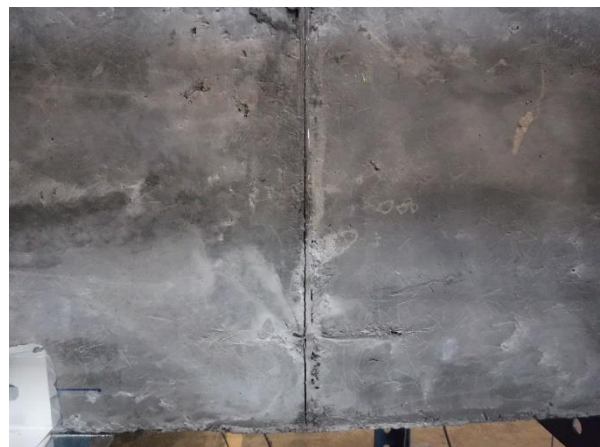
写真-4.4.25 等曲げ区間 下面側の目地状況
