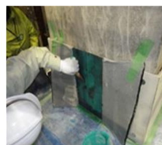
③ 炭素繊維シートへの樹脂塗布
