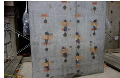
(12) PHb 施工完了
