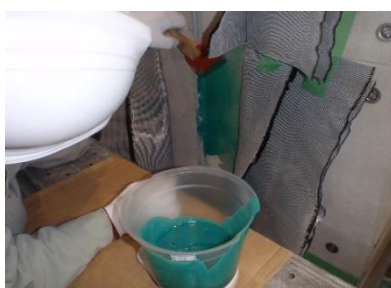
② ボード面への樹脂塗布
