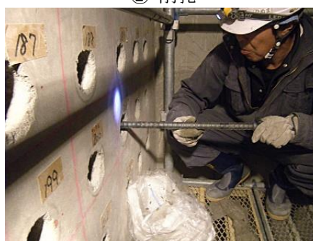
④ PHb の挿入・設置
