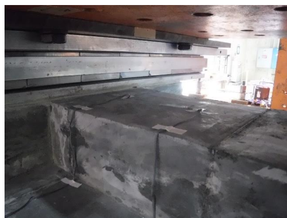
写真-4.4.16 載荷版付近の状況
