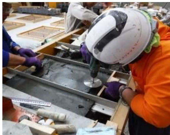
写真-4.4.4 超高強度繊維補強モルタルの締固め状況
