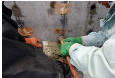
(11) かぶり部のモルタル注入
