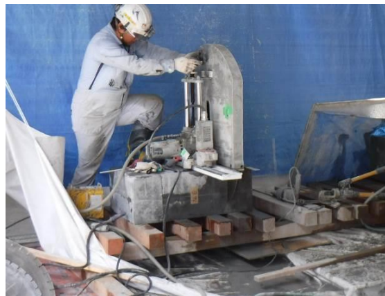
写真-4.4.8 ウォールソーによる切断状況
