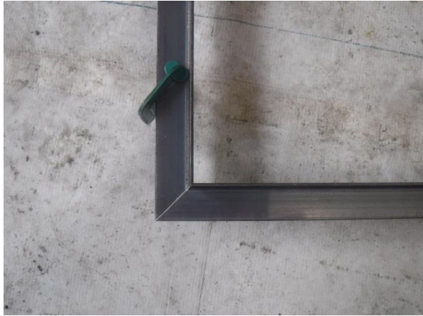
写真-4.4.35 No.3 目地材を突き合せた状況
