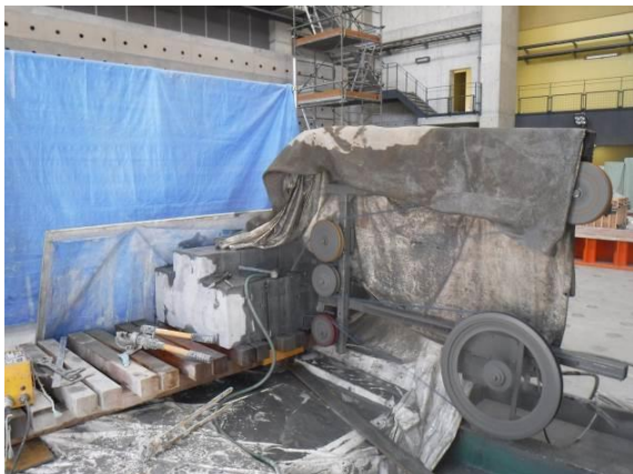
写真-4.4.7 ワイヤソーによる切断状況
