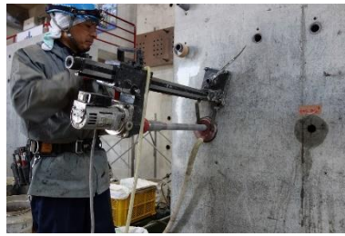
(2) 特殊コアドリルによる削孔
