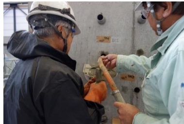
(8) PHb モルタルの注入
