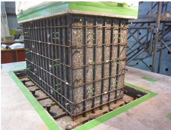
写真-4.4.36 アンカーの設置
