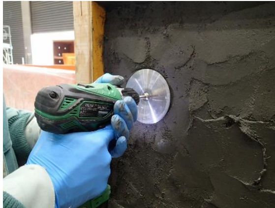
写真-4.3.1 専用機械による締固め状況
