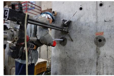
(3) 削孔長・削孔径の計測
