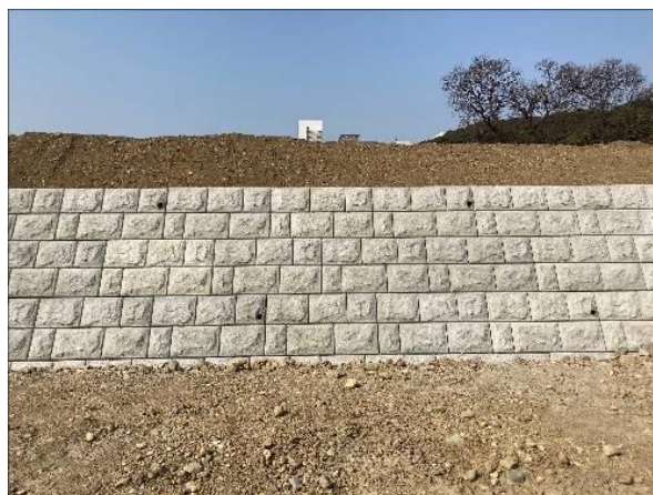
図-4 視距離 5m における現実空間の護岸ブロック
