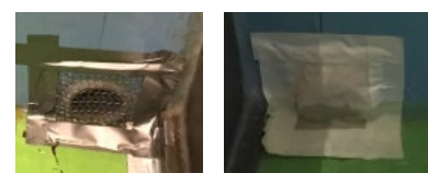
図4 排水孔呑口の処理方法 (左:メッシュ、右:不織布)
