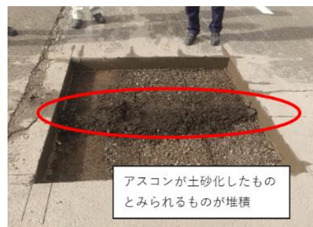
写真-3 開削した路盤面
