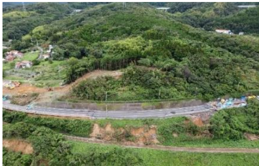
図-8 島根県出雲市多岐地区
