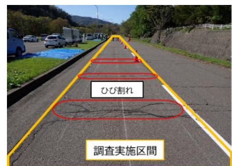
写真-1 調査箇所全景
