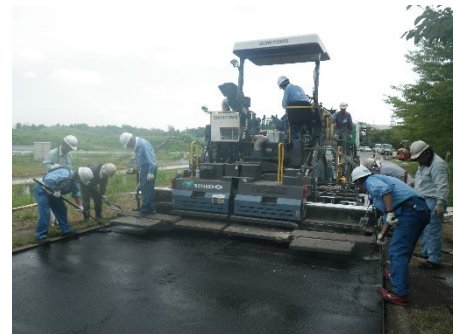
写真-4-7 敷きならし状況
