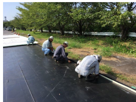
写真-4-5 成形目地設置状況
