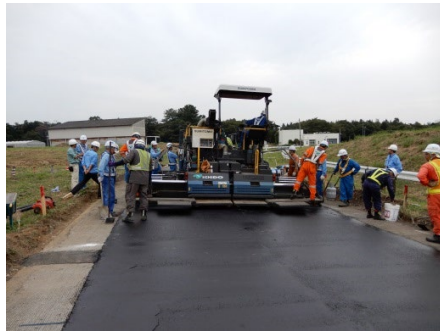
写真-1 施工状況
