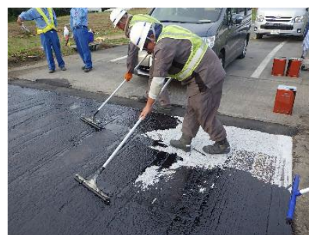
写真-3-4 プライマー塗布状況
