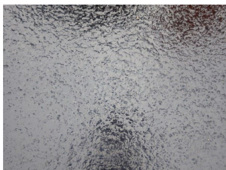
写真-3-8 仕上がり表面
