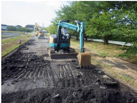
写真-4-1 舗装撤去状況
