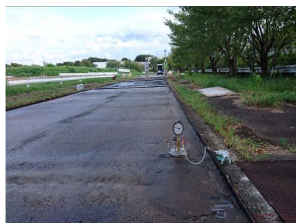
写真-4-14 透気試験状況
