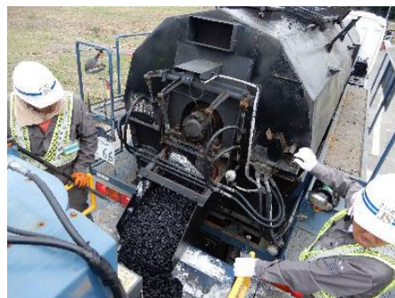
写真-3-6 荷下ろし状況
