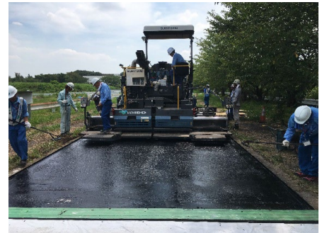
写真-1 舗設状況
