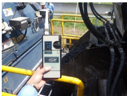
写真-4-10 荷下ろし時
