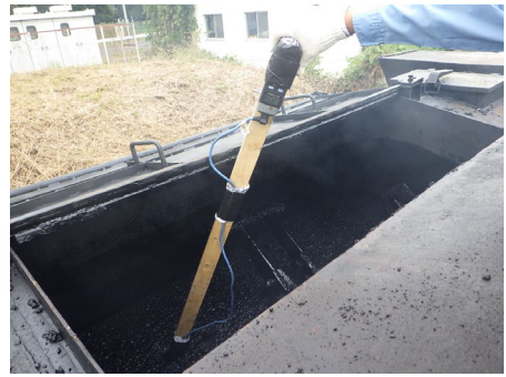
写真-4-6 温度測定状況
