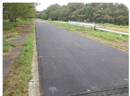
写真-4-9 完了状況
