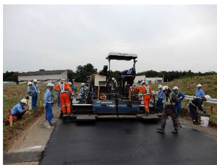
写真-3-7 敷きならし状況
