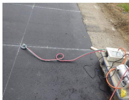
写真-3-14 透気試験状況
