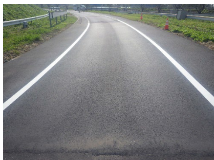
写真-3-9 完了状況
