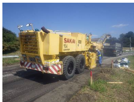
写真-3-1 舗装撤去状況
