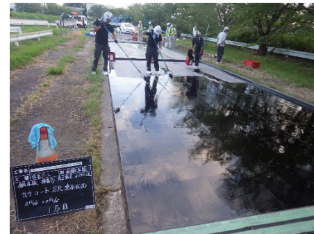
写真-4-4 プライマー塗布状況
