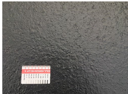
写真-4-8 仕上がり表面
