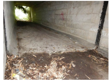
3) 継手部の段差
