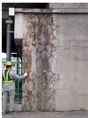
1) 橋台堅壁側面部
