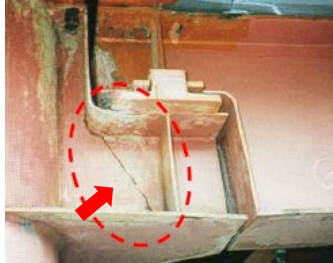
2) 桁端切り欠き部
