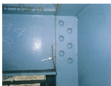
1) 横桁と縦桁の接合部 11)
