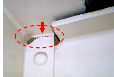
3) 対傾構取付部の垂直補剛材
