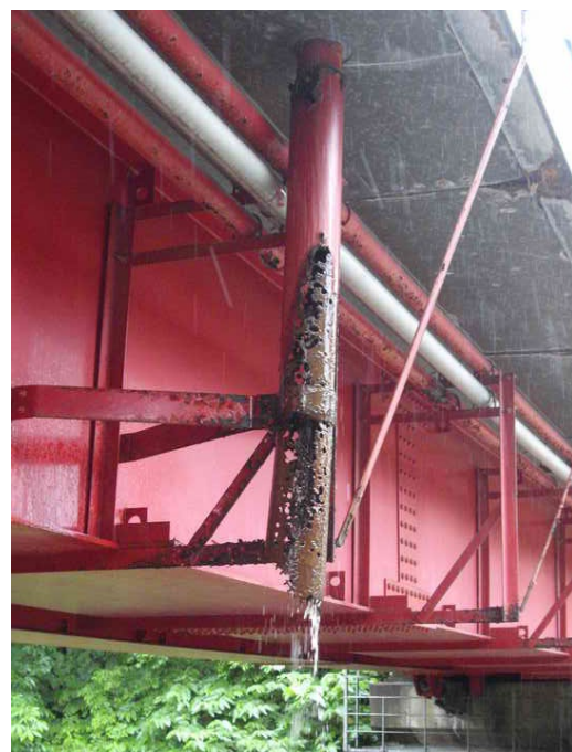
図 3-13-7 鋼製排水管の著しい腐食事例 59)
