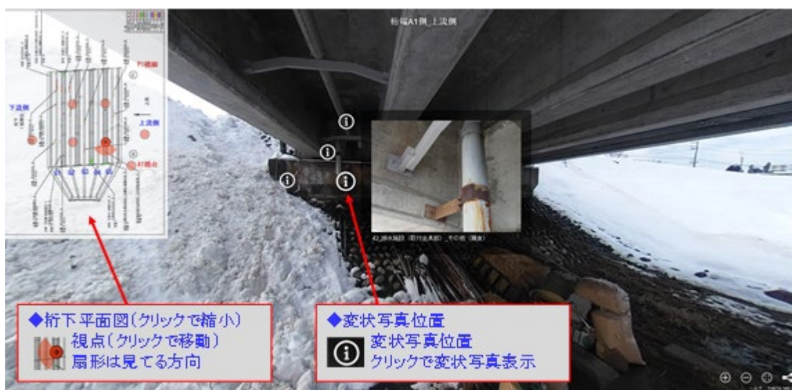
図4-2-16 SI橋 PCT桁(第1径間) [360度画像]
