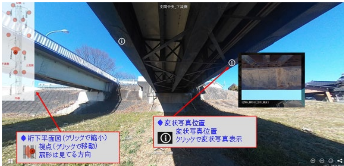
図 4-2-12 S 橋 鋼 I 桁 (第 6 径間) [360 度画像]
