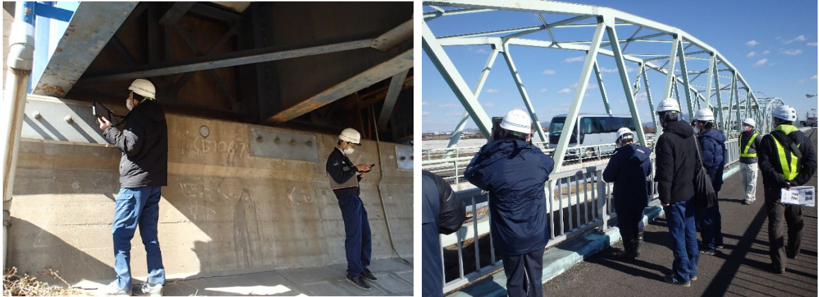
写真 4-2-3 現場検証状況 (S 橋)
