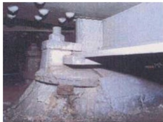
図 3-11-9 沓座モルタル内の空隙が原因で生じた変状の事例 27), 28)
