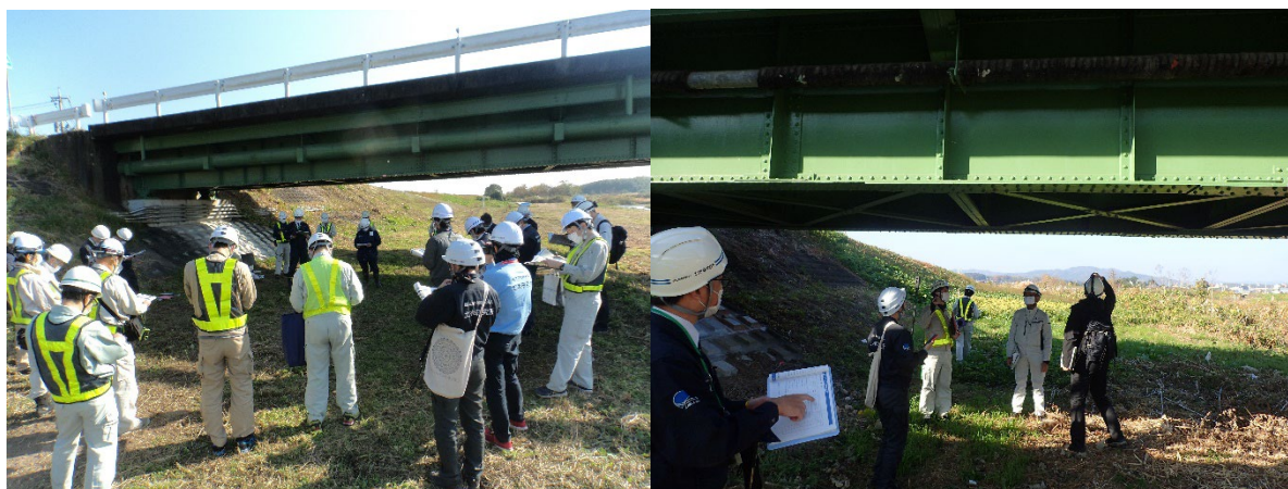
写真 4-2-1 検証状況 (H橋)
