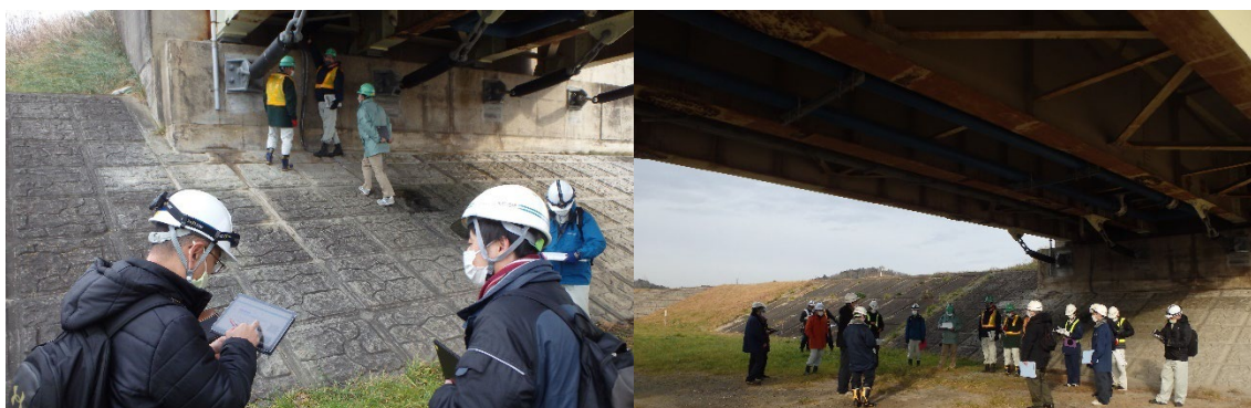
写真4-2-2 検証状況 (N橋)
