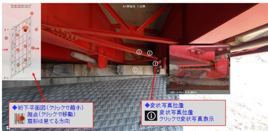
図4-2-15 G橋 鋼I桁(第1径間) [360度画像]
