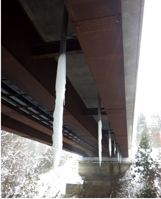
図 3-13-10 流末水の凍結事例 59) (12月中旬、前夜に降雨なし、最低気温-4℃)
