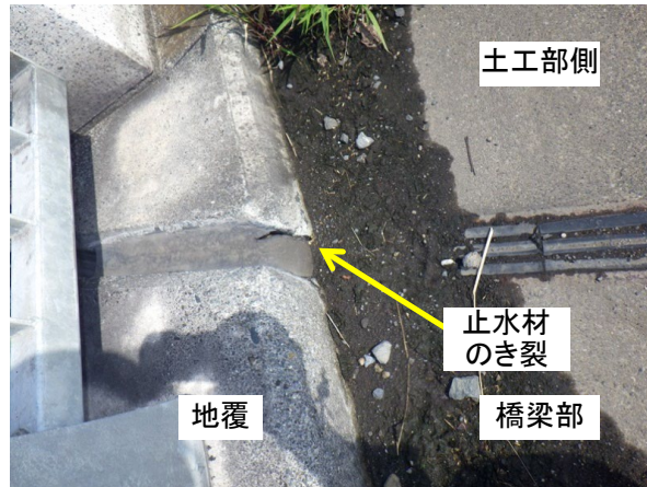
図 3-12-22 地覆部の止水材とき裂
