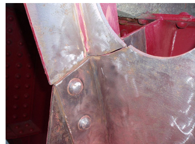
3) 斜材とガセットプレートの連結部 12)
