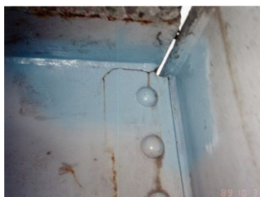
2) 主構と横桁との接合部
