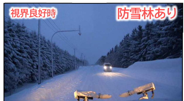
図-176 図-175 と同時刻の林整備箇所の視界良好な状況
