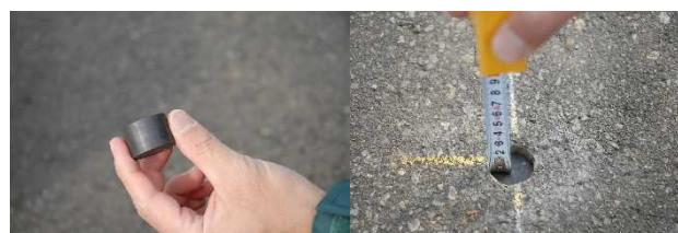
写真-12 磁気マーカ埋設状況
