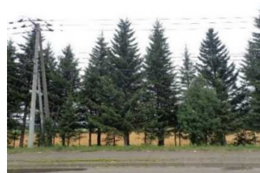
図-17 水上防雪林の外観
