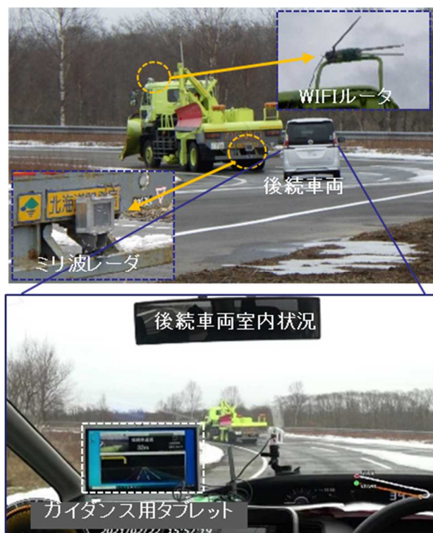
図-83 機器設置状況
