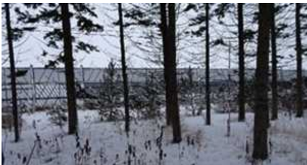
図-160 風上側林縁の防風ネット柵 (KP66.470～66.590)
