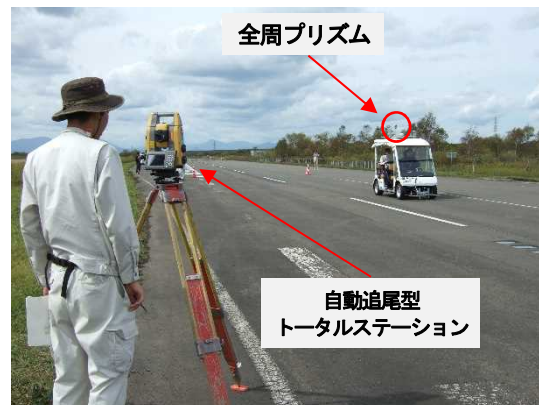
写真-10 TSによる計測状況 (直線部)
