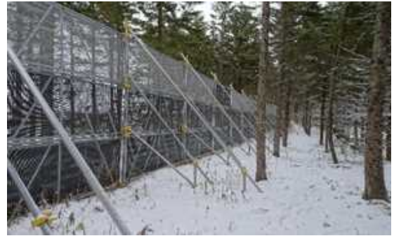
図-161 林内中央部の防風ネット柵 (KP66.590～66.700)
