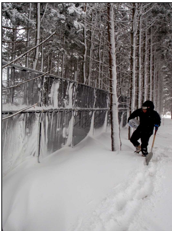
図-195 防風ネット柵前後に堆積された吹きだまりの状況
