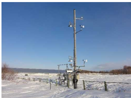
図-3 気象観測タワー（於：弟子屈吹雪観測サイト）
