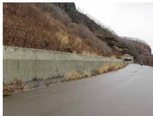
写真-2 落石防護擁壁
