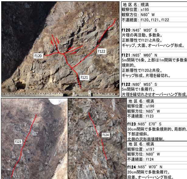
図-4.1 露頭で観察される亀裂の調査結果例
