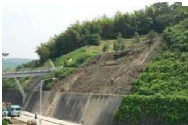
(a) 被災箇所状況 (再掲)
