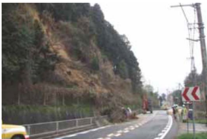
(a) 被災箇所状況
