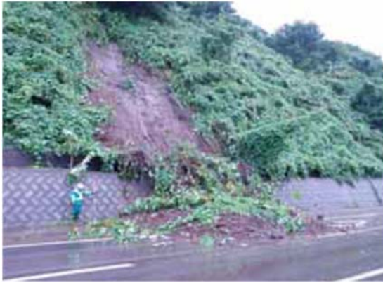
(a) 被災箇所状況
