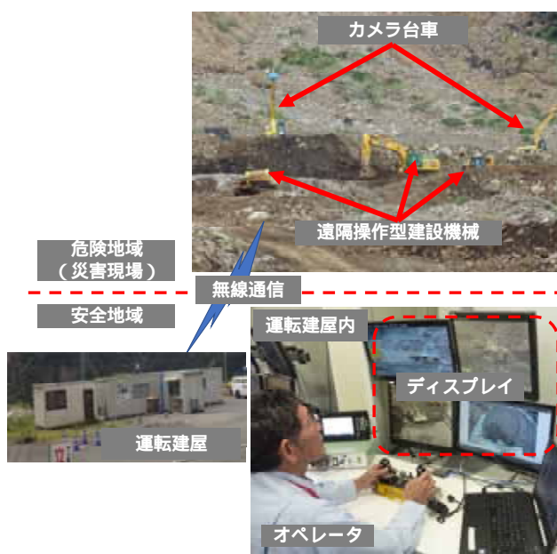
図-1 無人化施工概要（カメラ画像方式）
