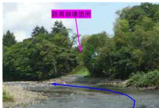
写真 2-10 河川増水による洗掘崩壊箇所の例
