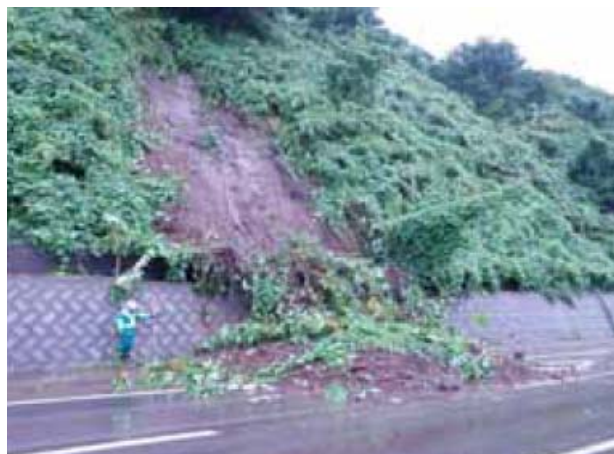
(a) 被災箇所の状況 (再掲)
