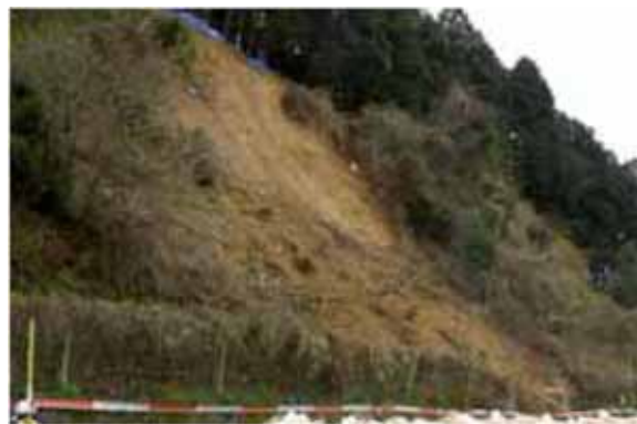
写真2-13 表層の風化による事例（地山：花崗岩）
