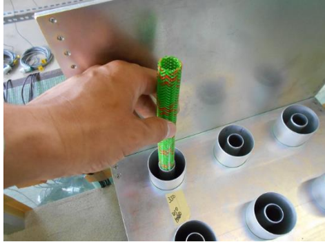
(f-4) パイプドレーン挿入状況
