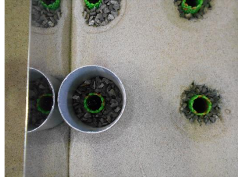
(f-5) ドレーン材投入後
