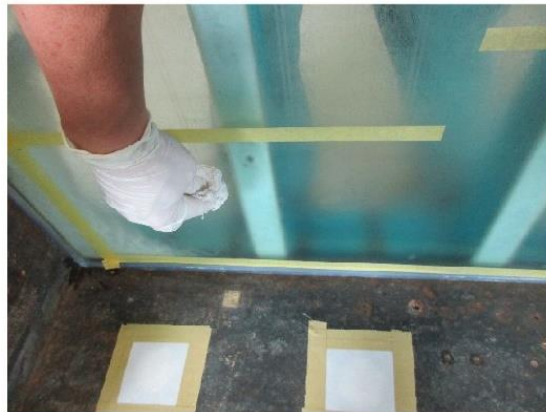
写真 5.2.2 コーティング剤塗布状況
