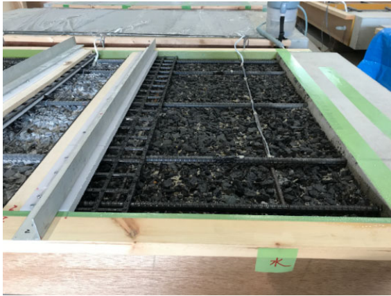
図-1.2.3.2 型枠の設置状況
