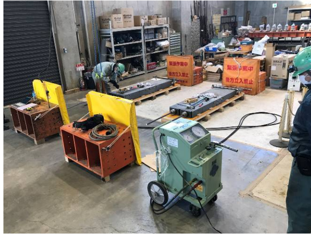
図-2.8.2.5 PC鋼材の緊張
