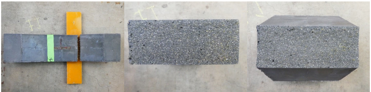
(c)床版-5 の側面と破断面
