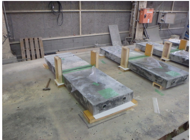
(d) 接合部型枠
