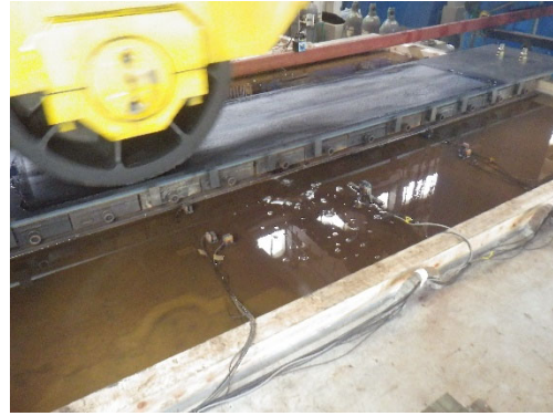
図-2.2.4.5 水張り下での変位計の状況
