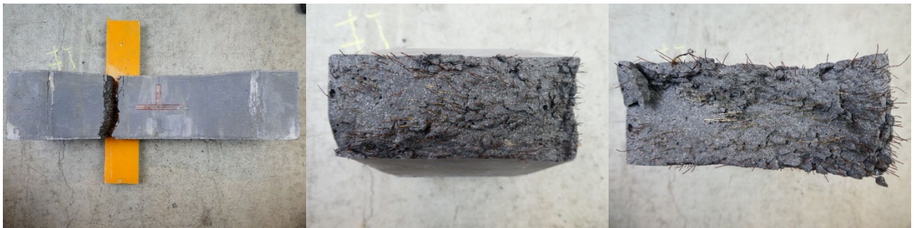
(c)床版(大)-2の側面と破断面
