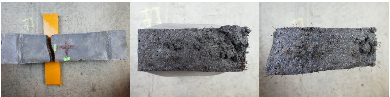
(c)床版 (小) -5 の側面と破断面
