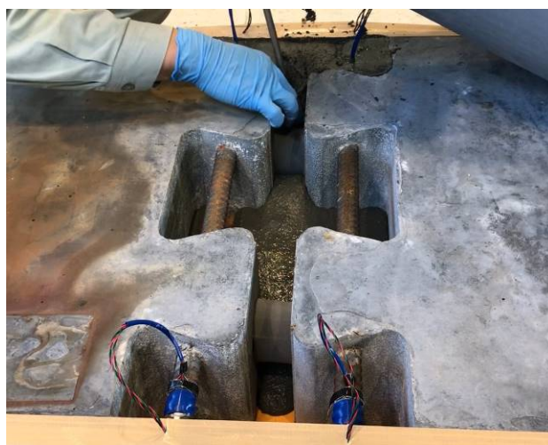
図-2.8.2.4 間詰め材 UHPFRC の打設
