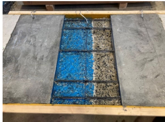
図-1.2.4.5 下地コンクリート処理（中央部）
