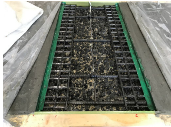
図-1.2.3.5 中央部打設前状況（散水処理）
