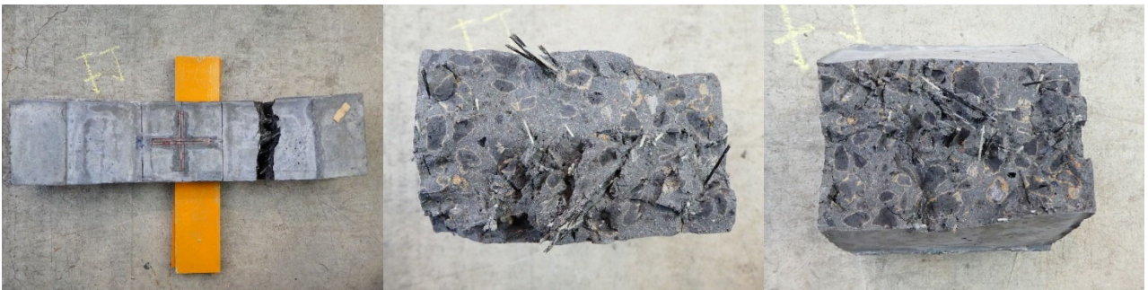
(d)床版-6 の側面と破断面
