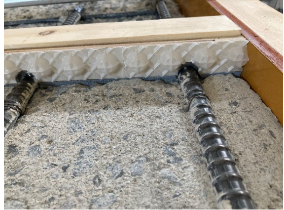
図-1.2.5.2 型枠の設置状況 (KJ)
