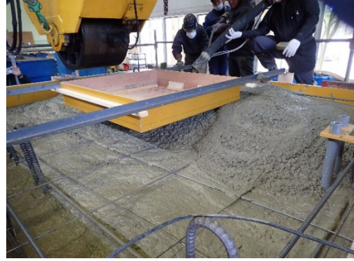
(b)母材のコンクリート打設の状況
