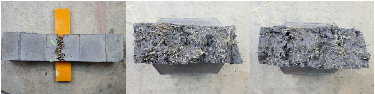
(c)床版(間) -5 の側面と破断面
