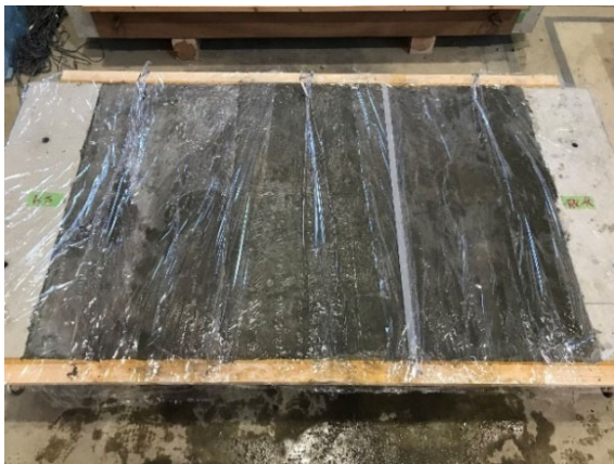
図-1.2.4.6 補修材施工（中央部）
