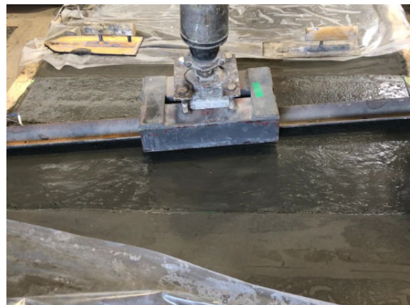
図-1.2.3.7 補修材上面仕上げ状況
