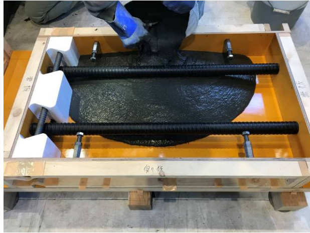
図-2.8.2.2 UFC 打込み状況
