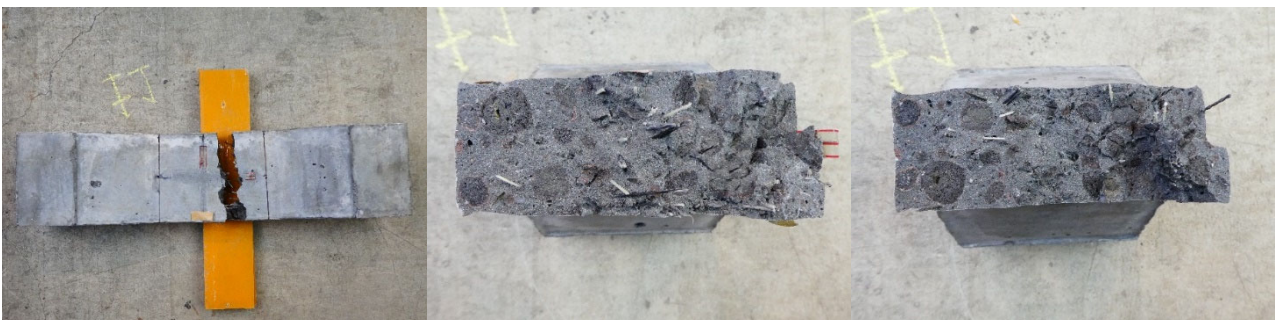
(d)床版-3 の側面と破断面
