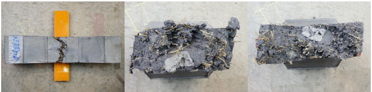
(c)床版 (間) -2 の側面と破断面
