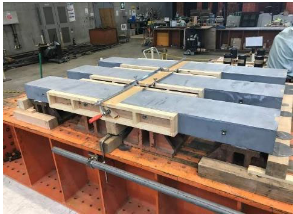
(d)間詰め型枠
