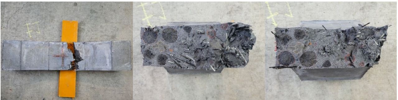
(c)床版-5 の側面と破断面
