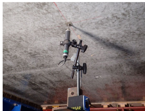
図-2.2.4.3 下面の変位計の設置状況
