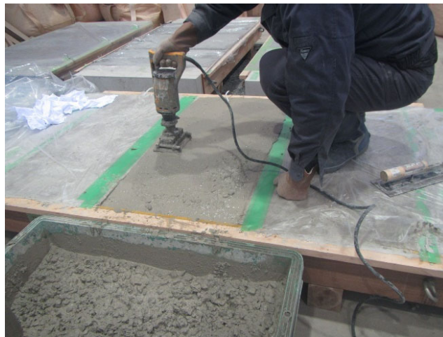
図-1.2.2.4 補修材の施工状況
