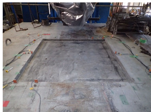
(h)撤去後の母材上面
