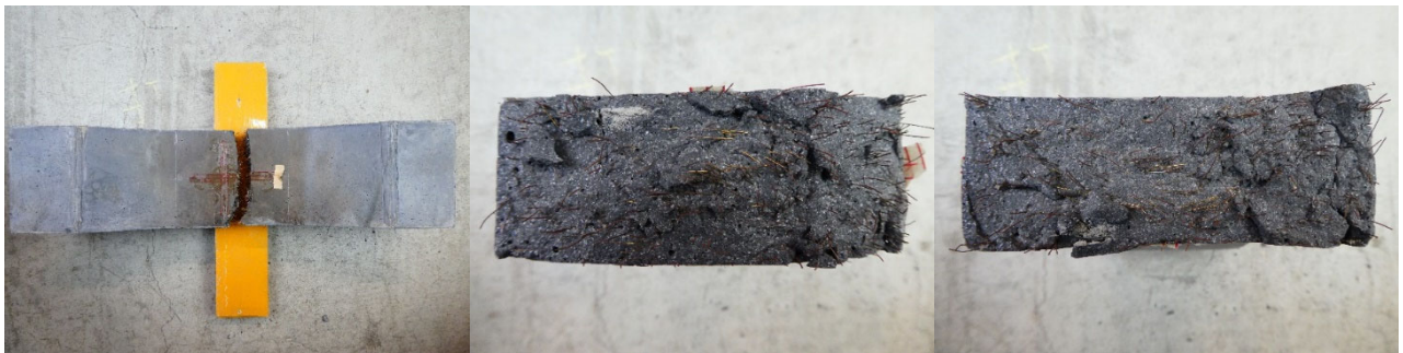
(d)床版(小)-3の側面と破断面
