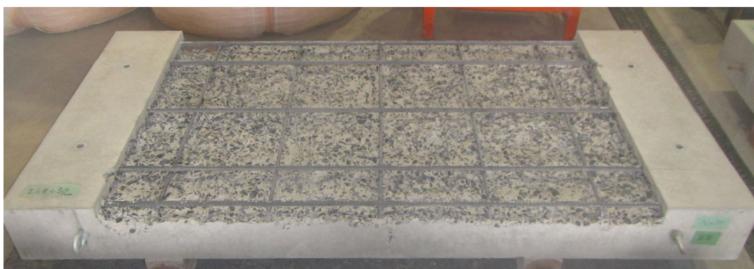
図-1.2.1.2 ウォータージェットによるはつり後の全体状況 (目標はつり深さ 60mm)
